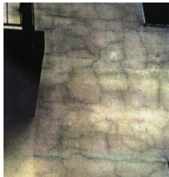
Figura 1 – Fissuras Mapeadas.
