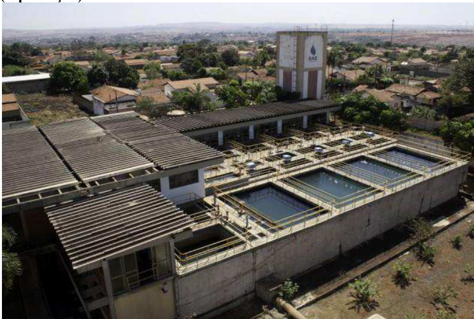
Figura 14- Imagem aérea da estação de tratamento de água de Ituiutaba-MG (reprodução):
