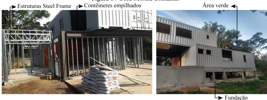
Figura 17 Obra Mostra Container
