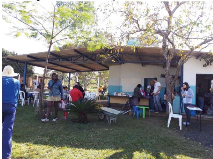
Figura 24 Vista da construção atual
