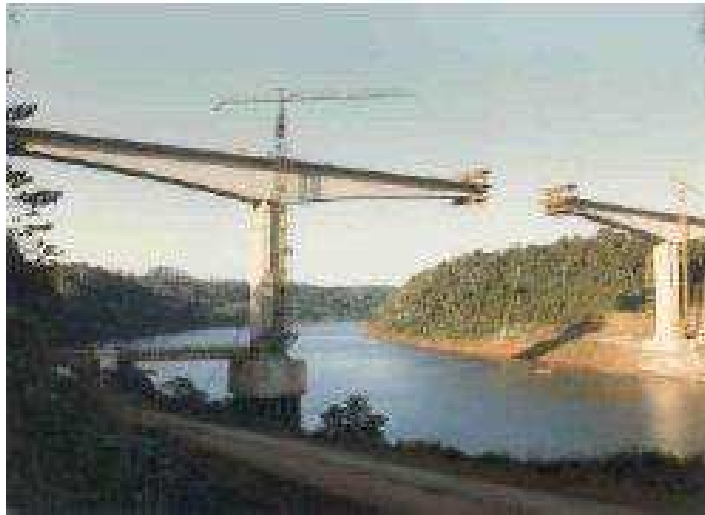
Figura 2 - Ponte protendida em balanços sucessivos.
