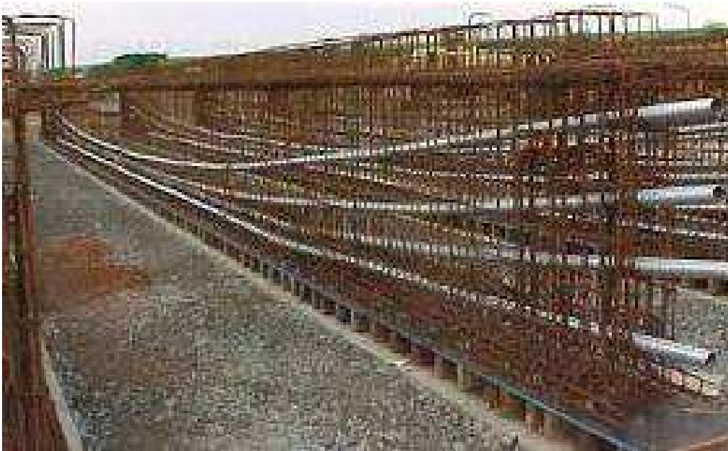
Figura 5 - Exemplo de curvatura de protensão.
