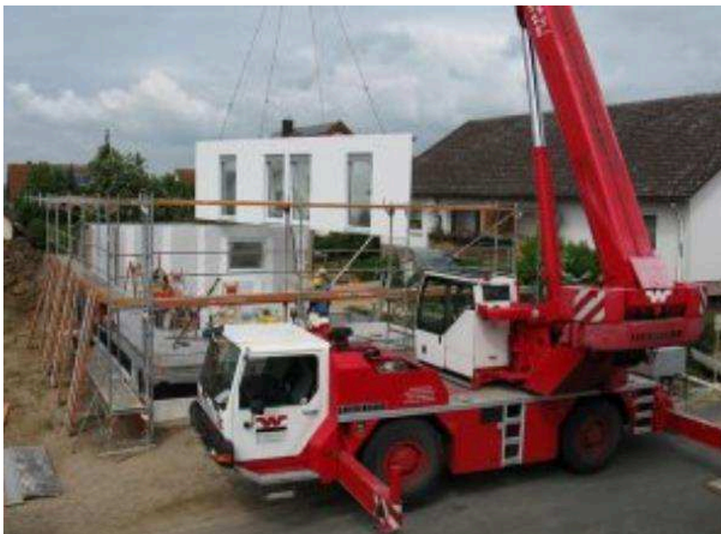
Figura 1 – Utilização de pré-moldado na construção de resistências.
