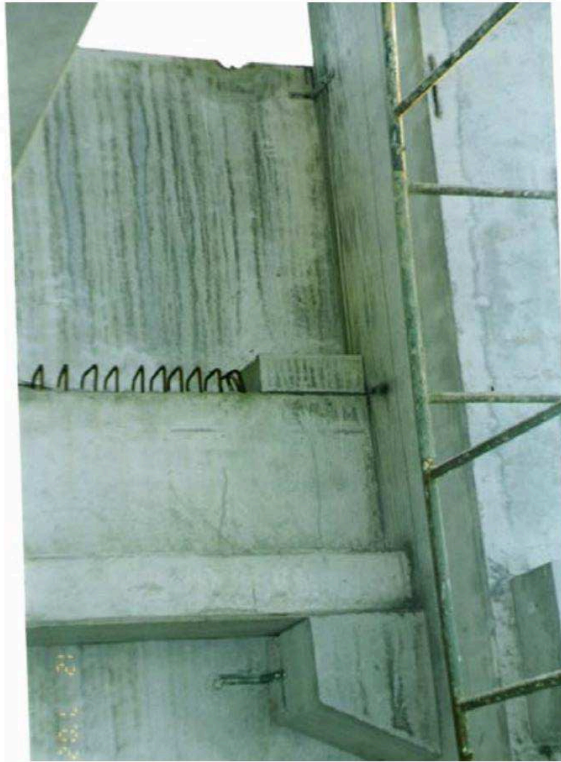
Figura 13 - Consolo de fixação vertical dos painéis de vedação.
