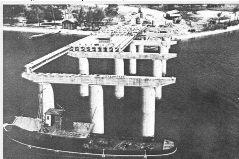
Figura 3 - Concreto protendido na ponte do Galeão - Rio de Janeiro.
