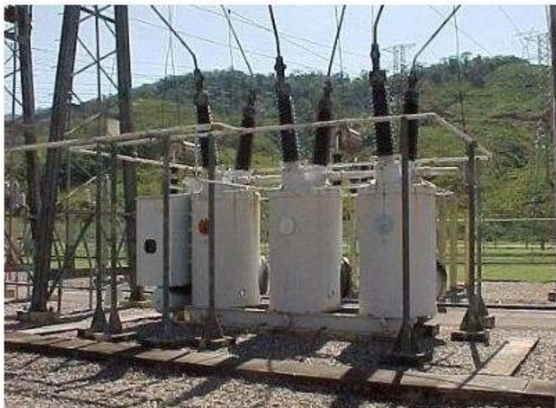
Figura 12 - Disjuntor a grande volume de óleo [14]
