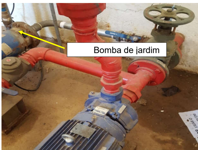
Figura 23 - Tubulação de sucção.
