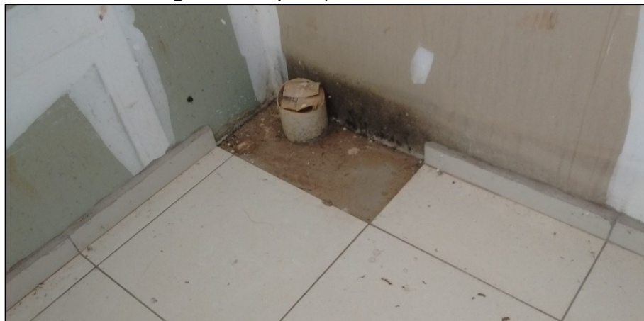
Figura 27 - Aplicação de revestimento
