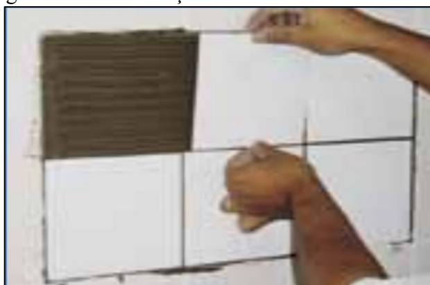
Figura 20 – Manutenção com revestimento cerâmico
