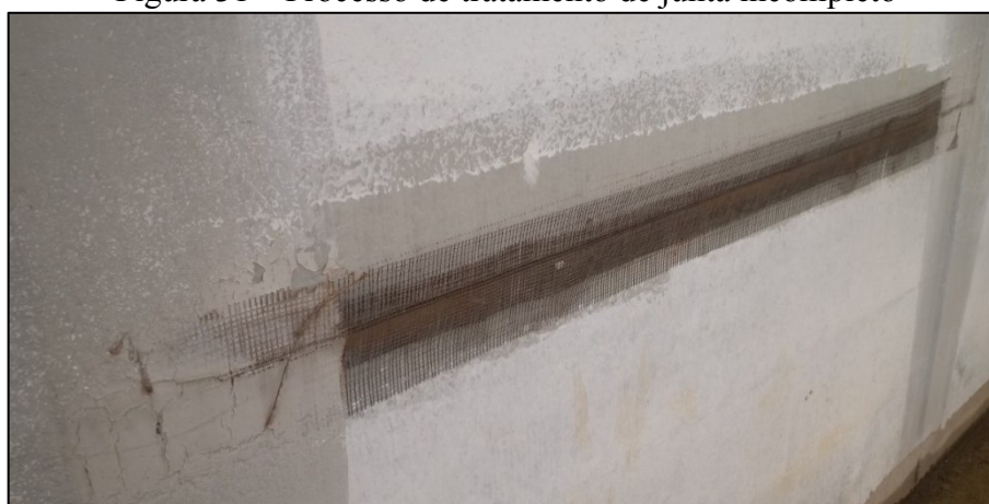
Figura 31 – Processo de tratamento de junta incompleto
