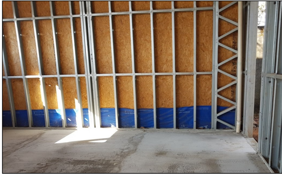
Figura 22 – Aplicação de placas OSB na UBS Novo Umuarama
