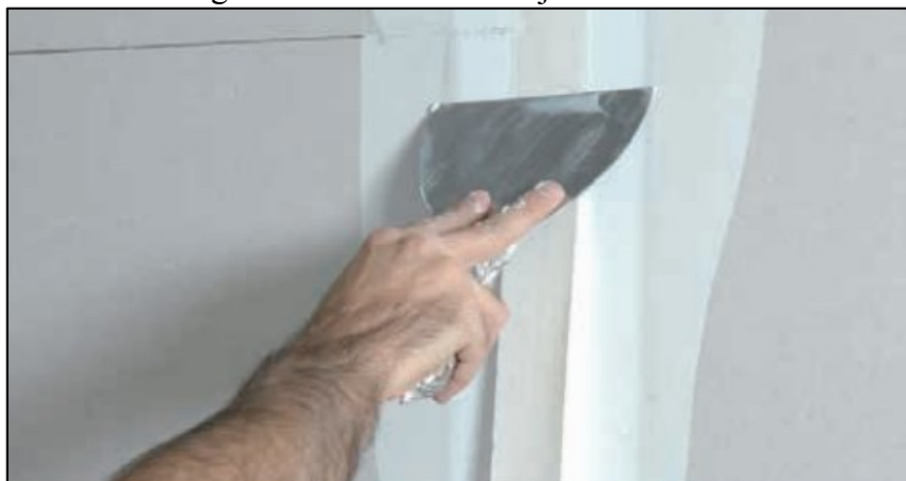
Figura 9 - Tratamento de juntas internas
