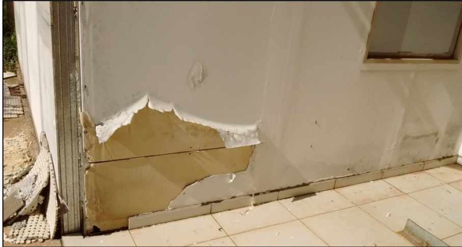
Figura 59- Uso de placa ST em lugar de placa cimentícia
