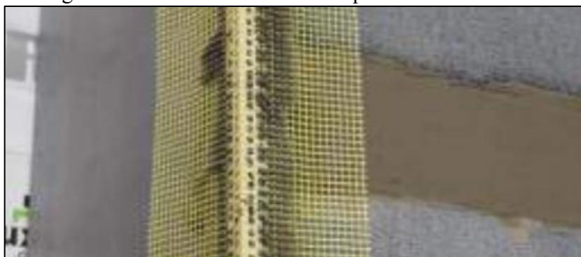
Figura 10 – Fita em tela de vidro aplicada em cantoneira
