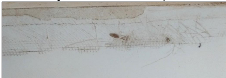
Figura 55 – Local de tratamento de junta
