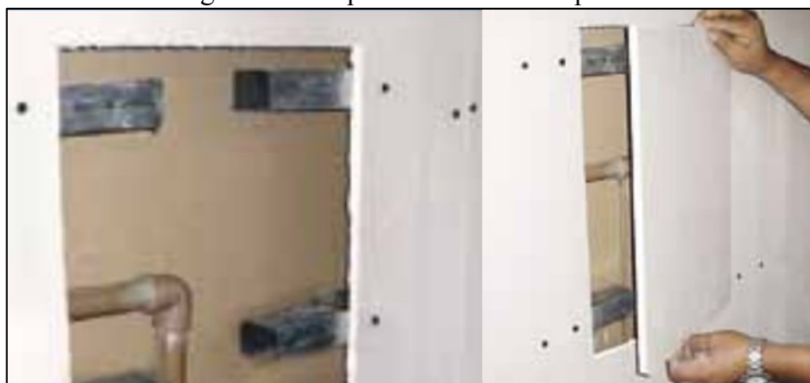
Figura 19 – Reparo de abertura de parede
