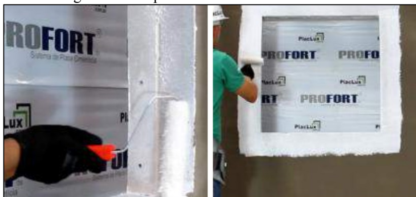
Figura 13 – Impermeabilizante nos acabamentos
