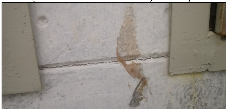
Figura 30 – Processo de tratamento de junta incompleto
