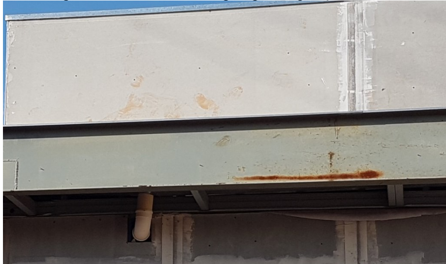
Figura 79 – Pontos de ferrugem pela exposição ao clima
