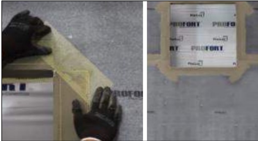
Figura 11- Reforços em ângulos e quinas de portas e janelas
