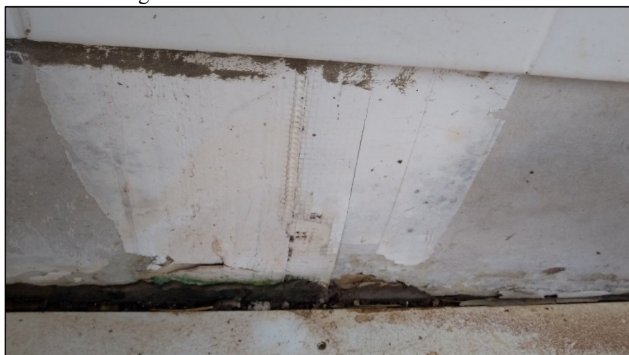
Figura 33 – Fita telada em tratamento interno
