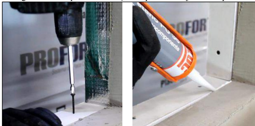
Figura 12 – Impermeabilização requadros de janelas e portas
