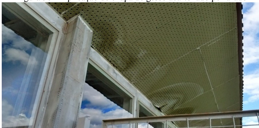
Figura 56 – Aplicação de chapa de gesso acartonado perfurado
