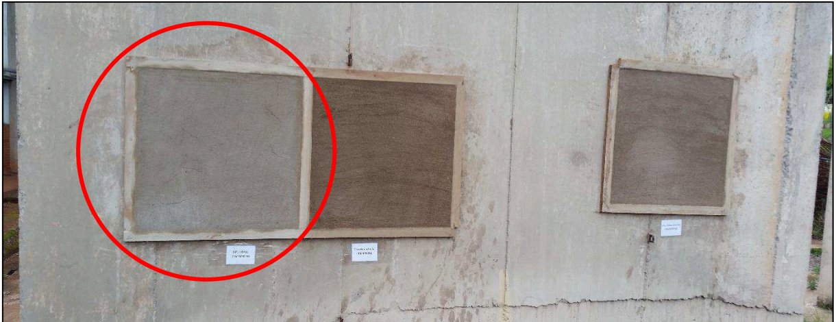
Figura 7 – Painéis finalizados na parte externa e interna da parede
