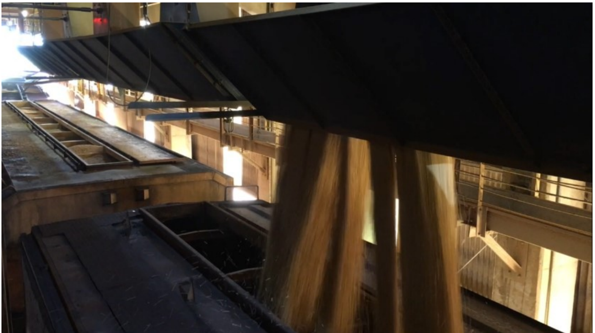
Figura 3.1 Carregamento ferroviário de soja (Fonte: própria autora, 2018)
