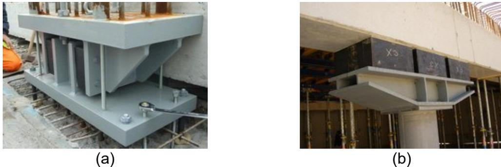
Figura 1. 1 – Amortecedores viscoelásticos utilizados na Construção Civil como rolamento elastomérico: a) Aplicado em reforço horizontal de uma estrutura de aço; b) Aplicado em pilares (extraída de Magebasa, 2018)
