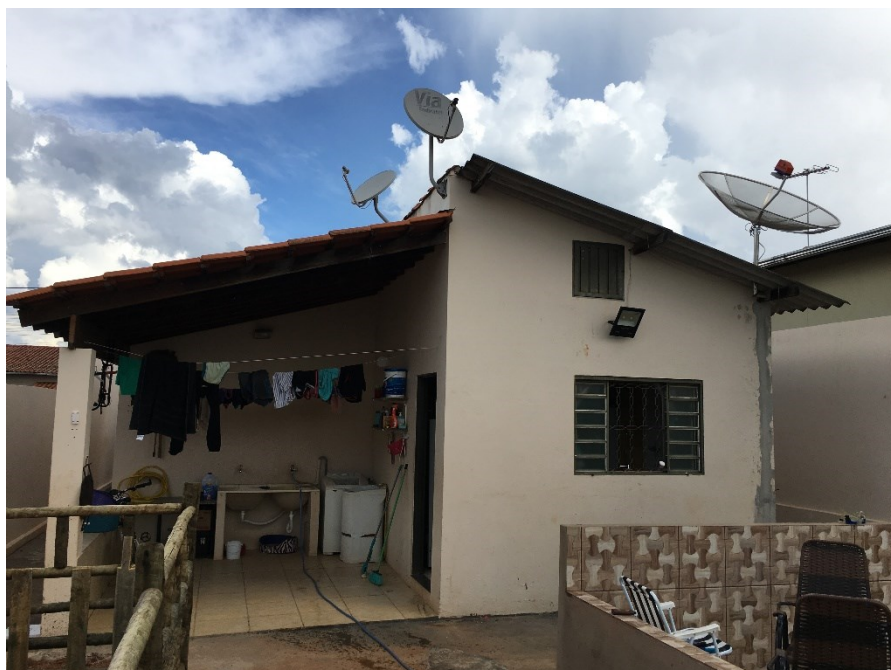
Figura 21 – Fotografia do local onde será instalado o sistema fotovoltaico.
