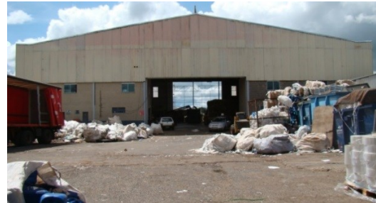
Figura 8 - Frente do galpão - Classe II
