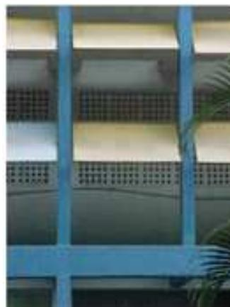
Figuras 30, 31 e 32: Hall do Pavimento-Tipo; Aspectos externo e interno dos brises e cobogós na fachada principal, demonstram a má iluminação resultante da utilização desses recursos. Fonte: FONTES, 2003, p. 108
