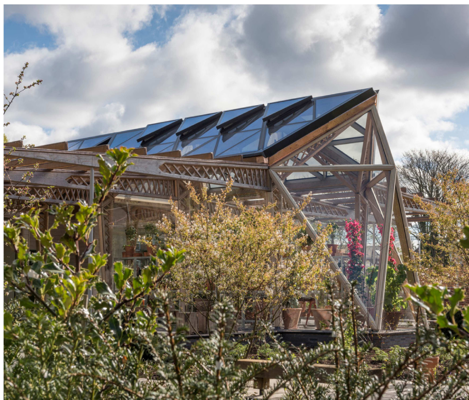
Figura 21. Cobertura translúcida cobre o jardim interno e mantém iluminação. Foto Nigel Young, 2013.
