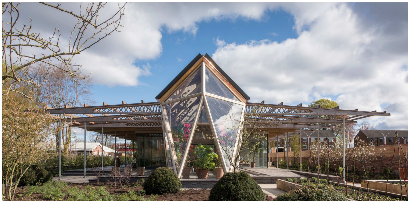
Figura 20. Acesso frontal do centro de tratamento de câncer. Foto Nigel Young, 2013.
