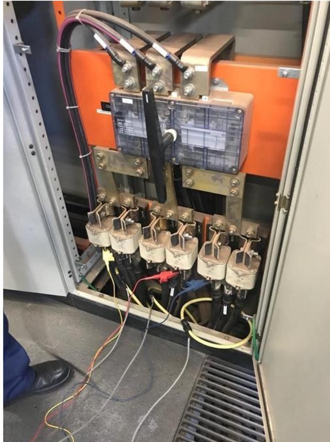
**Figura 4.20:** Conexão de cabos no quadro elétrico.
