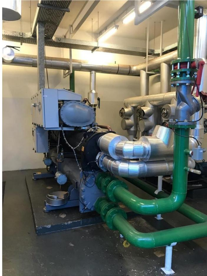
**Figura 4.17:** *Chiller* fabricante Carrier modelo 30 HX instalado.
