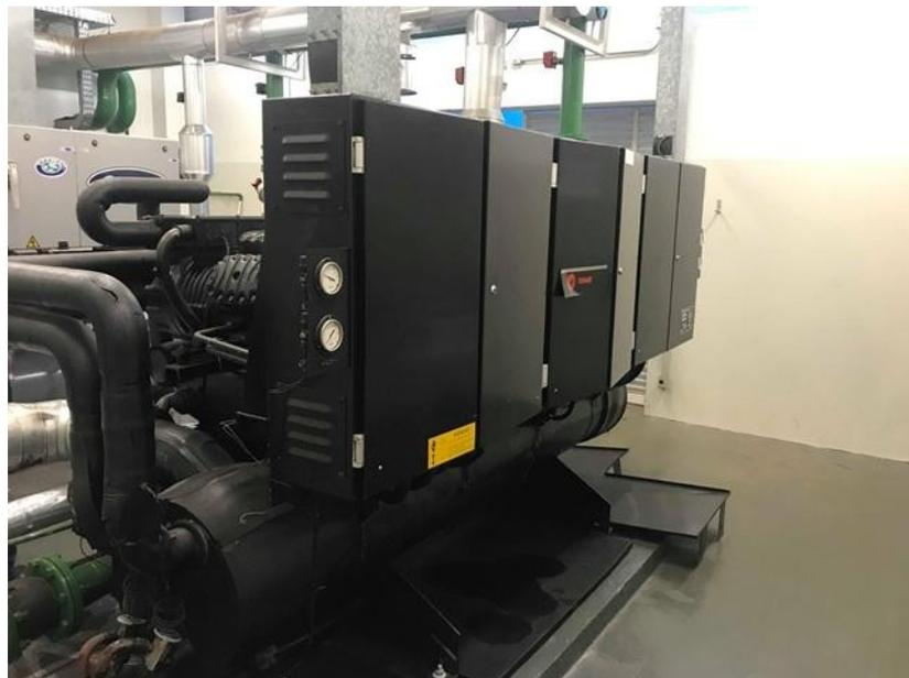
Figura 4.1: *Chiller* TRANE de condensação à água existente. Fonte: Autor.
