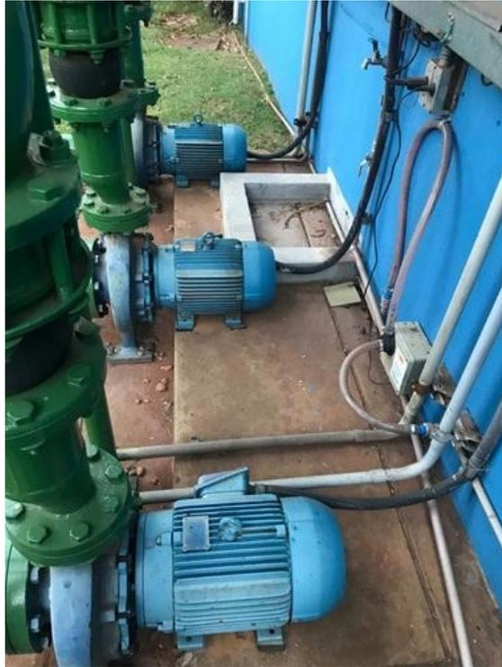
**Figura 4.4:** Bombas de água condensada. Fonte: Autor.
