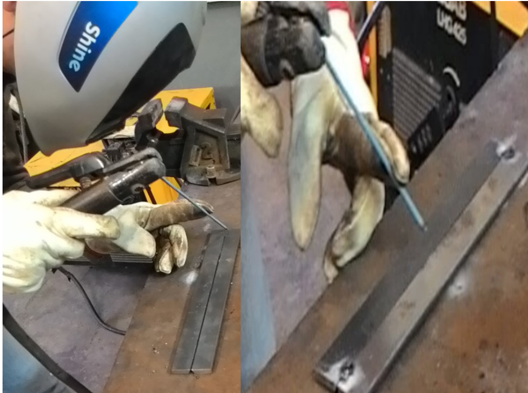
Figura 21- Ponteamento realizado com eletrodo revestido
