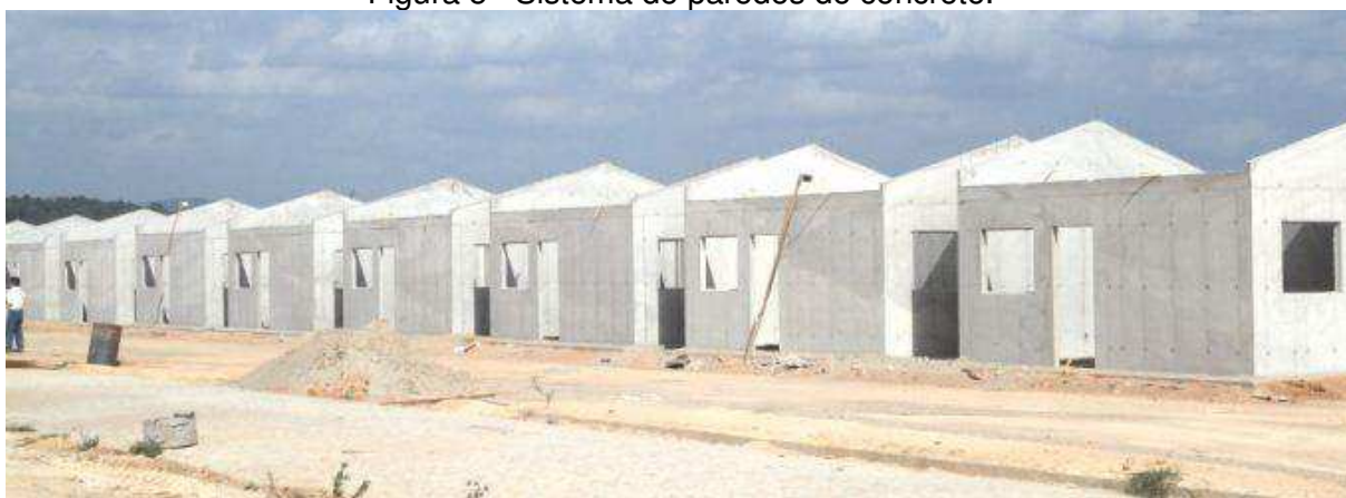
Figura 5– Sistema de paredes de concreto.
