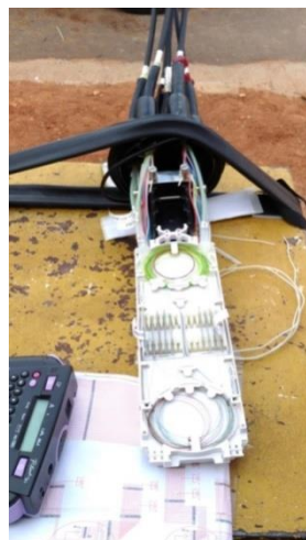
Figura 23 - Instalação de uma caixa de emendas
