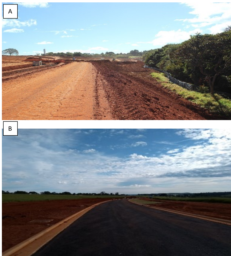
Figura 6. Alterações na cobertura do solo: (A) Aberturas das estradas de terra e implementação do sistema de esgoto (julho/2017), (B) Estradas pavimentadas (fevereiro/2018). Fazenda Granja Marileuza, Uberlândia-MG. Fotos: Bergamo,N.C.S.B
