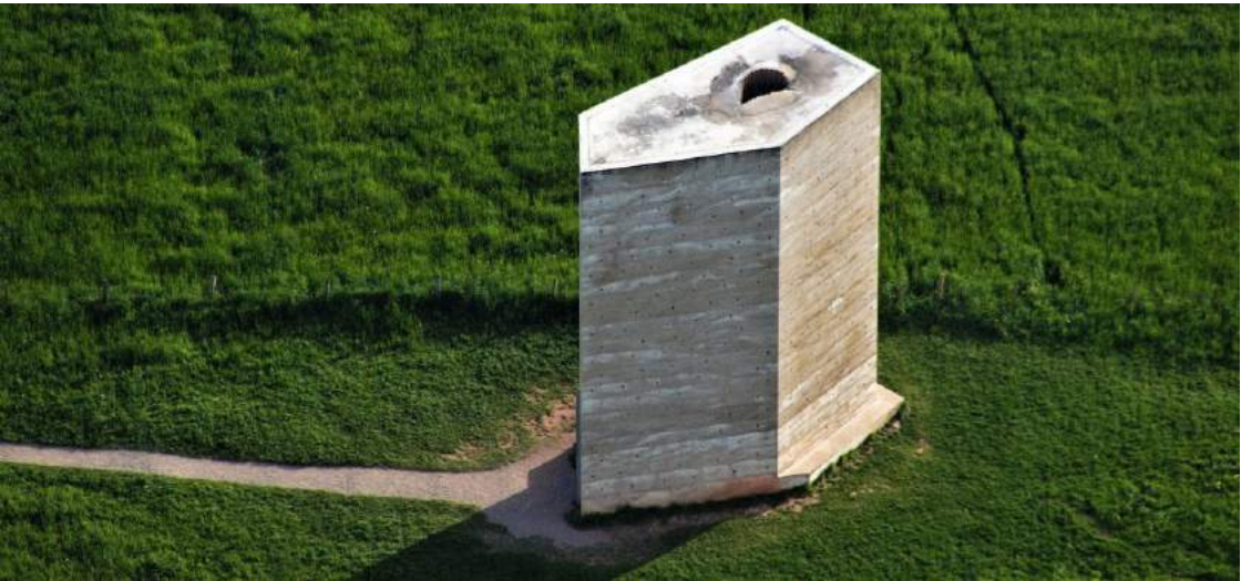
Fig.25: Capela Bruder Klaus- Mechernich, oeste da Alemanha. Fonte: Fotografia de Samuel Ludwig e Thomas Mayer. Fonte: < http://www.archdaily.com.br/br/01-55975/capela-de-campo-bruder-klaus-peter-zumthor > Acesso em: out. 2017.
