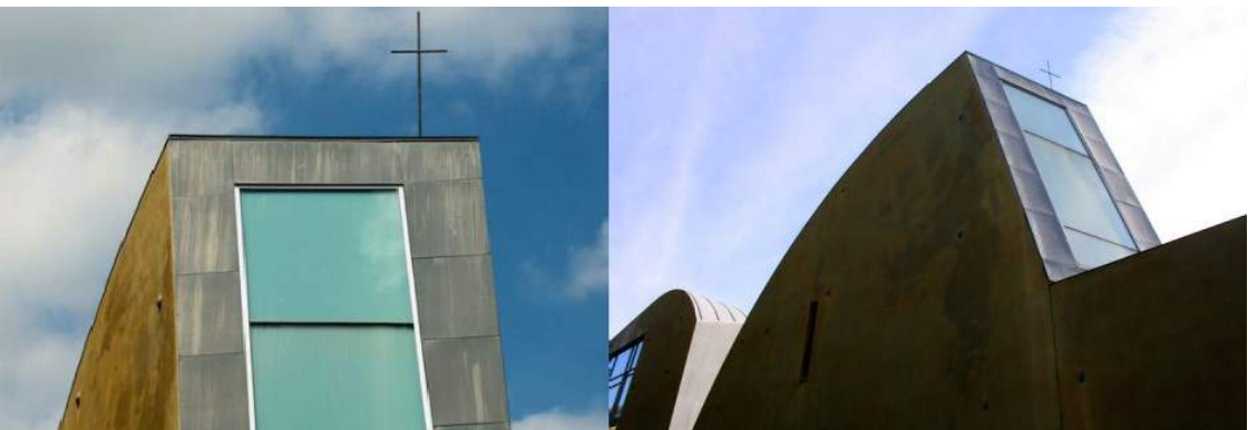
Fig.19: Vista Externa- Janela acima do portal de entrada, delimitando uma vista oblíqua, voltada para o céu, e uma iluminação direcionada à via processional do interior.
