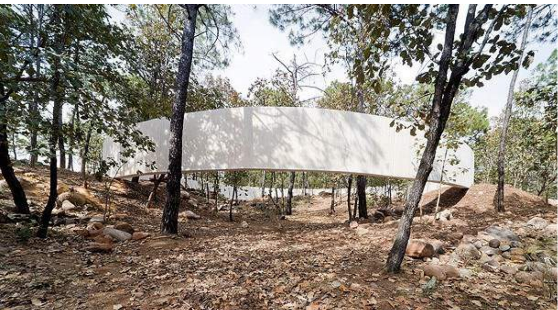
Fig.59: Perspectiva - Derek Dellekamp e Periférica, ano de 2011. Fonte: < https://www.archdaily.com.br/14566/ruta-del-peregrino-mexico > Acesso em: out. 2017.
