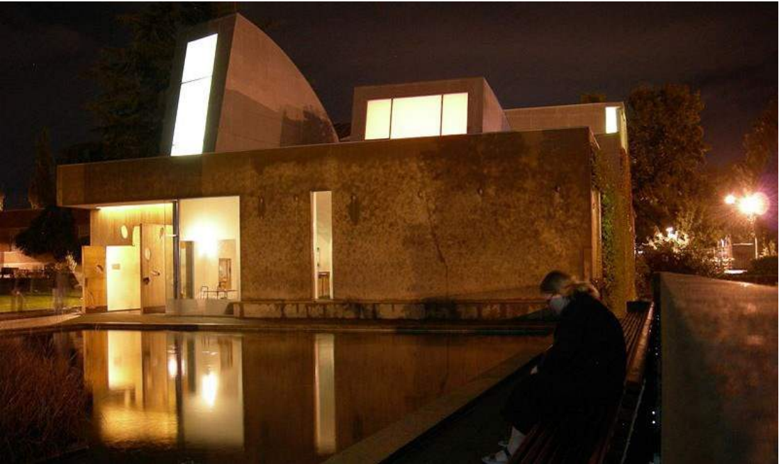
Fig.23: Vista Externa Noturna- Fachada principal, com destaque luminoso.
