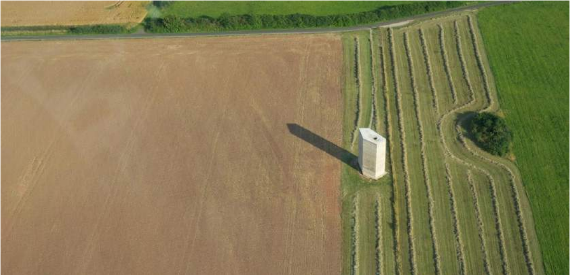
Fig.35: Vista Aérea - Capela Bruder Klaus, Alemanha.
