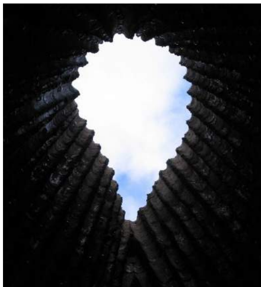
Fig.27: Abertura superior- Relação com a simbologia sagrada, iluminação e equilíbrio térmico.
