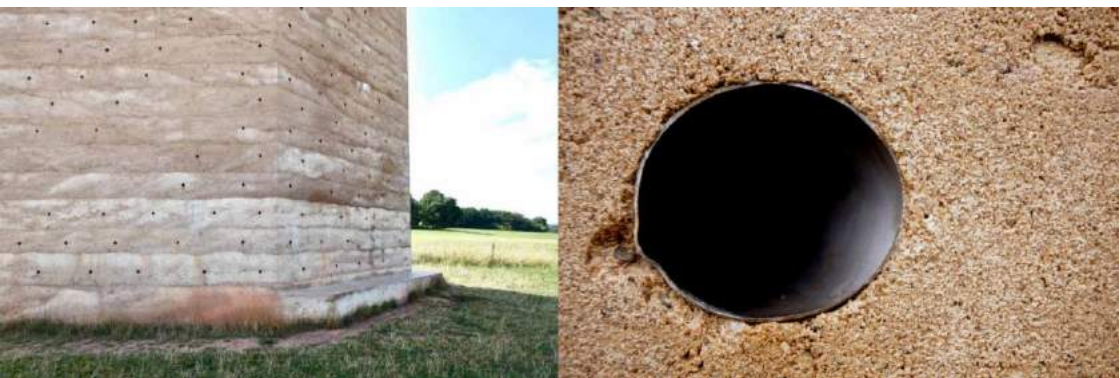
Fig.28: Pequenos orifícios distribuídos por todas as faces do volume, voltados à iluminação e ao equilíbrio térmico.
