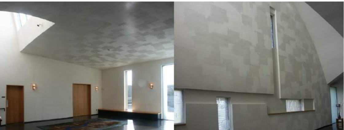
Fig. 14: Detalhe construtivo- Teto e paredes com textura, nártex e corredor de procissão.
