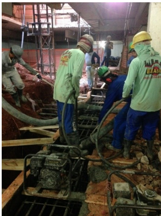
Figura 43 - Concretagem do bloco P37 e P38
