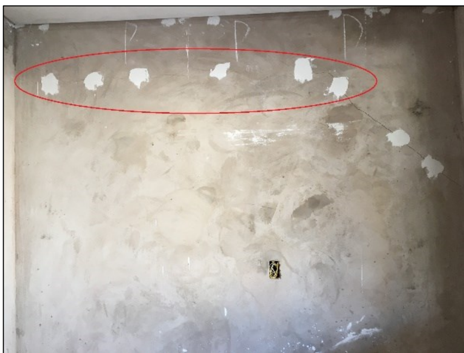
Figura 18 – Fissura no encunhamento (parede-viga)
