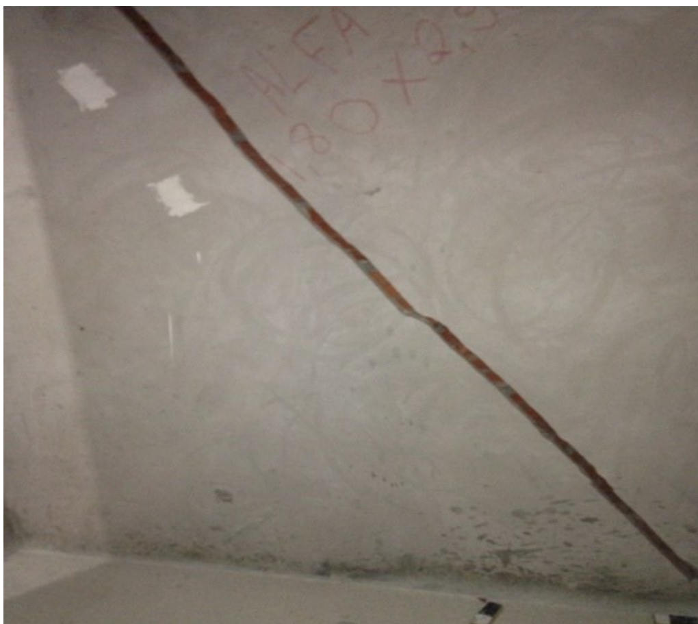
Figura 17: Trinca em alvenaria de subsolo
