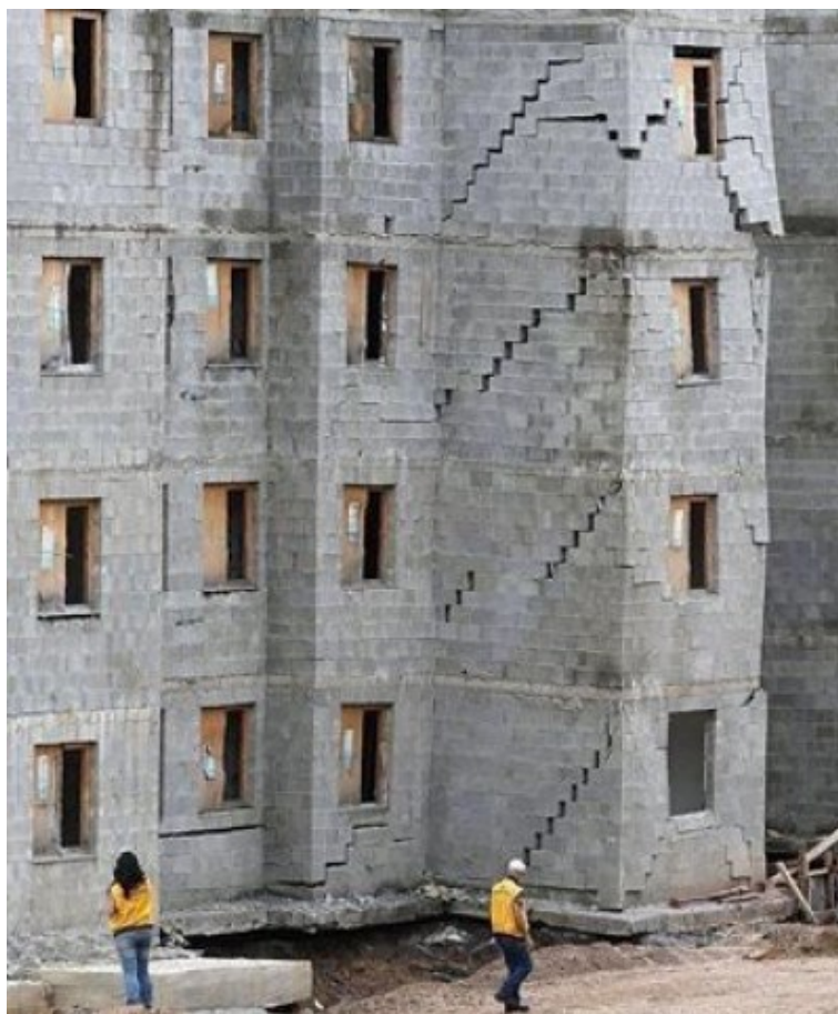
Figura 11 - Fissuras inclinadas provocadas por recalques diferenciais
