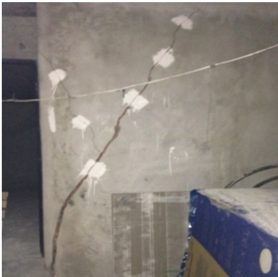
Figura 19 - Trinca em alvenaria de subsolo após calafetação com produto elastomérico
