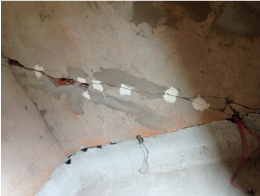
Figura 20 - Trinca em alvenaria no Mezanino Lazer
