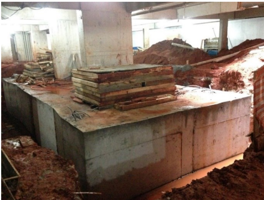
Figura 41 - Escavação ao redor do bloco P37 e P38 para a execução do reforço
