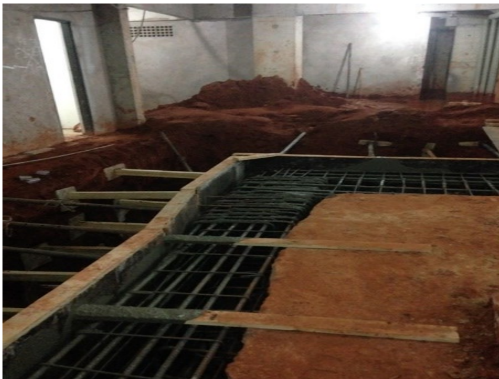
Figura 42 - Fôrmas e armação do reforço do bloco P37 e P38
