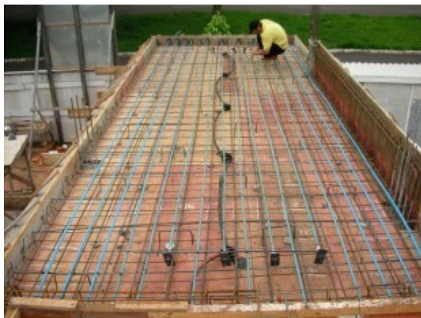
Figura 16 - Protensão sem aderência
