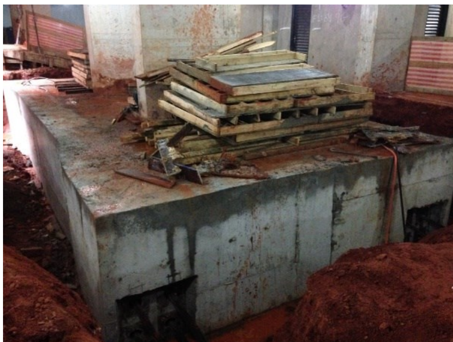
Figura 44 - Bloco P37 e P38 quase finalizado após o reforço
