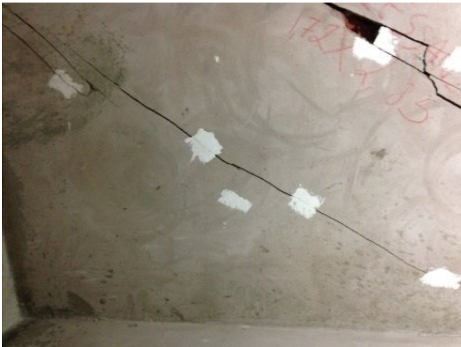
Figura 21 - Trinca em alvenaria no Mezanino Garagem
