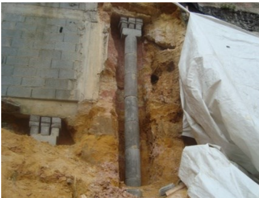
Figura 4 - Estaca tipo Mega
