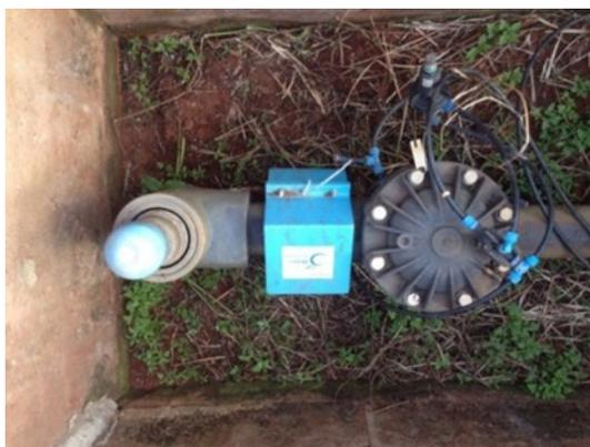
**Figura 1-** Instalação do magnetizador no sistema de irrigação.
