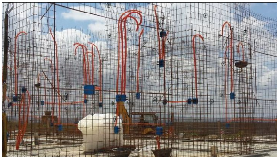
Figura 2.3: Montagem das instalações prediais.
