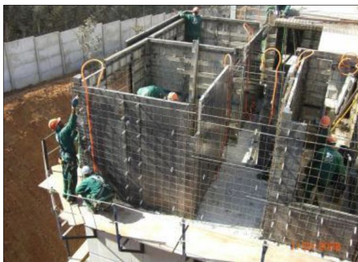
Figura 2.5: Montagem dos painéis do sistema paredes de concreto.
