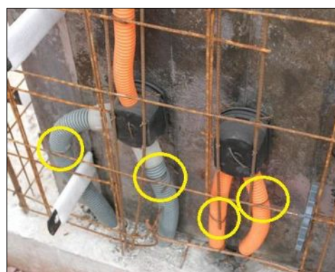
Figura 2.4: a) Espaçador; b) Amarração com arame recozido.
