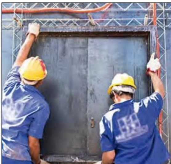
Figura 2.6: Montagem de gabarito para esquadria.
