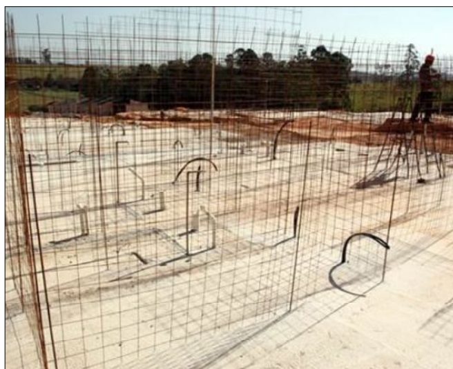
Figura 2.2: Execução de montagem de armaduras para paredes de concreto.
