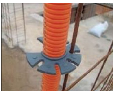
Figura 2.4: a) Espaçador; b) Amarração com arame recozido.
