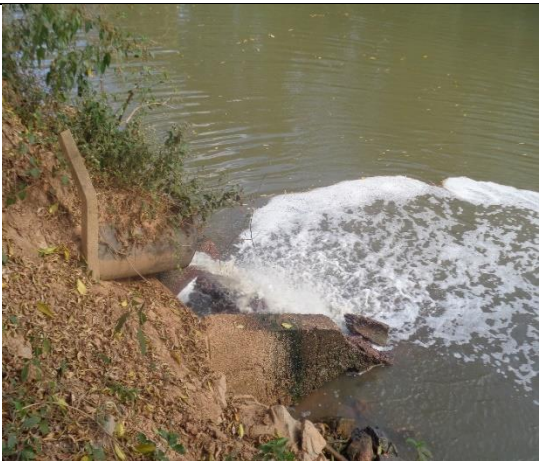
Ponto de lançamento de efluente industrial. Há dissipador (sistema de escadaria). Bairro Jardim Paulistano.
