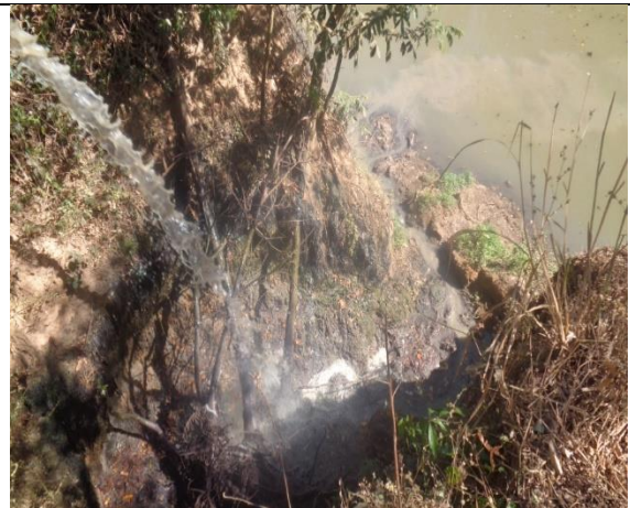
Ponto de lançamento de efluente sem dissipador. Bairro Sorriso.
