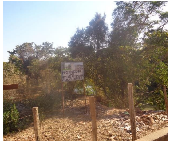
Lançamento de resíduos (entulhos) na borda da APP.
