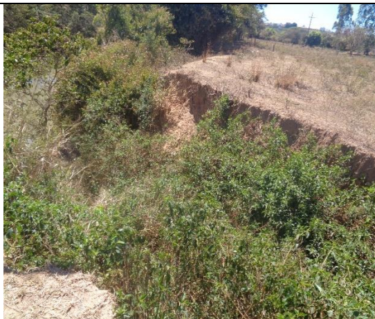
Escoamento superficial de águas pluviais.
