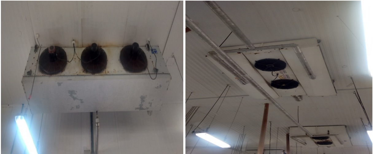
Figura 13 - Evaporador da esquerda, convencional e da direita, evaporador bidirecional.
