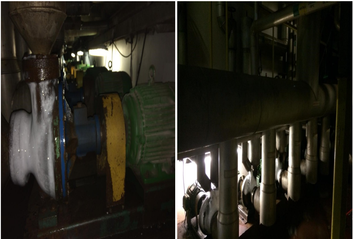
Figura 11 - Bombas centrífugas. Fluido de trabalho: AMÔNIA.
