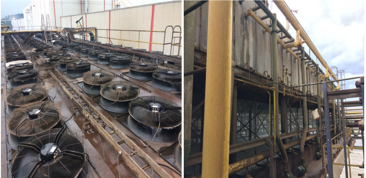
Figura 6 - Condensador evaporativo.
