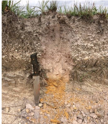
Figura 6.20: Perfil de materiais cascalho-arenosos com camada orgânica.
