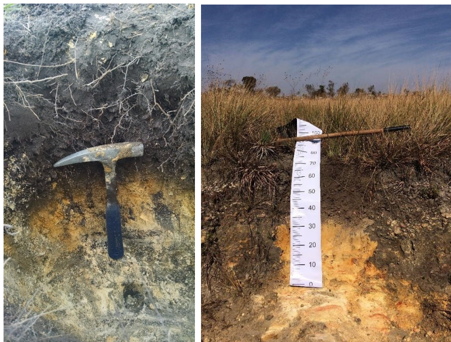
Figura 6.5: Perfis de materiais cascalho-arenosos, sobre a rocha alterada, com presença de matéria orgânica na camada superficial.
