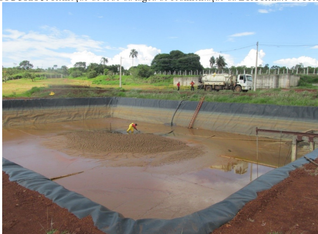
FIGURA 3: Remoção de lodo da lagoa de sedimentação da ETA Renato de Freitas.
