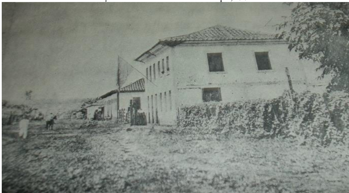
FIGURA 4. Ituiutaba: construção do edifício da Câmara Municipal, 1901
