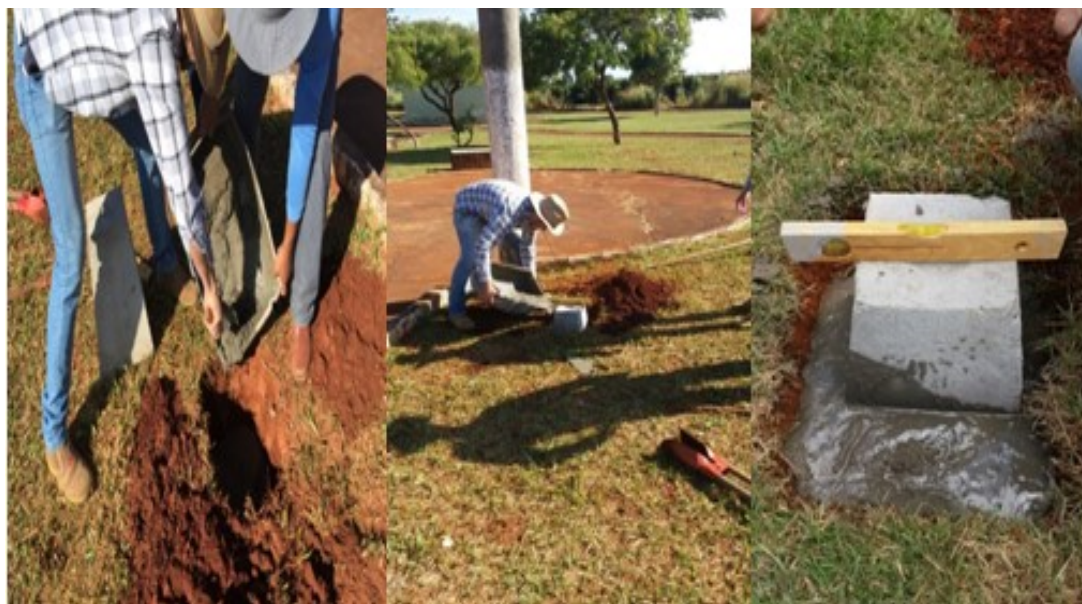
Figura 9– Equipe realizando a implantação dos marcos.
