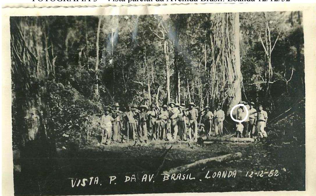
FOTOGRAFIA 3 - Vista parcial da Avenida Brasil. Loanda 12/12/52
