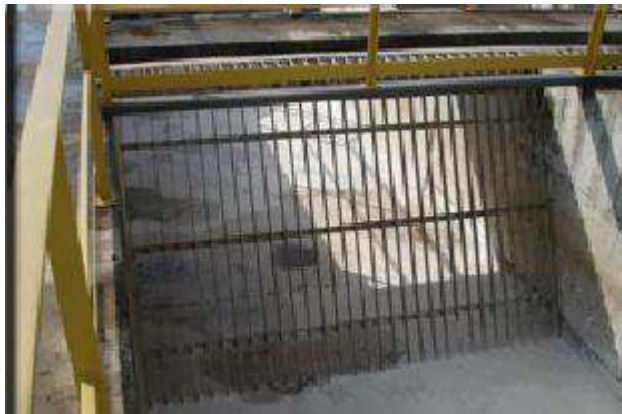
Figura 2.1.1 - Gradeamento para remoção de sólidos grosseiros. Fonte: COPASA.
