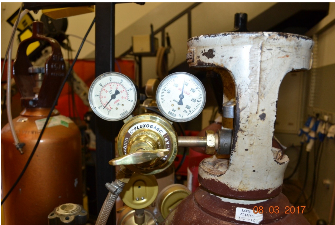
Figura 3.4 - Medidores de pressão e vazão utilizados.
