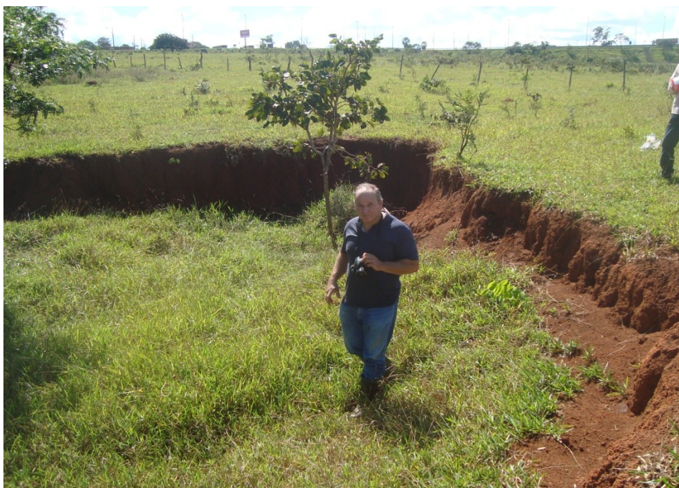
Figura 12 – Erosão a montante da nascente do Córrego Lagoinha a 269 metros, divisa com as terras proposta de loteamento – próximo a divisa com Bairro Santa Luzia – Uberlândia – MG.
