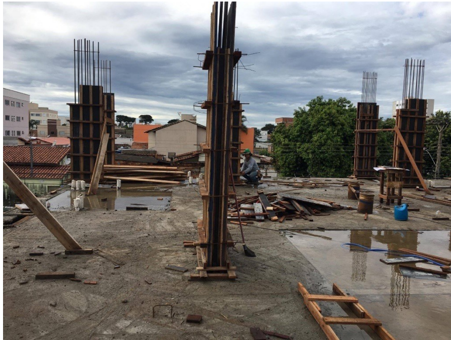
Figura 1 - Uso temporário da madeira em formas de concretagem
