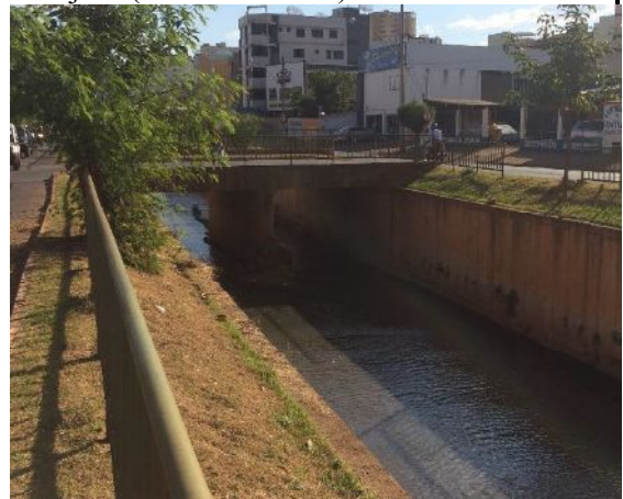
FOTO 20 – Vista à jusante do córrego do Monjolo (área canalizada).
