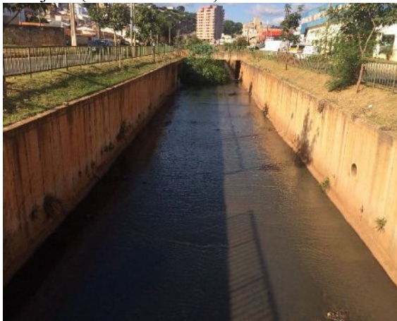
FOTO 19 – Vista à montante do Córrego do Monjolo (área canalizada).
