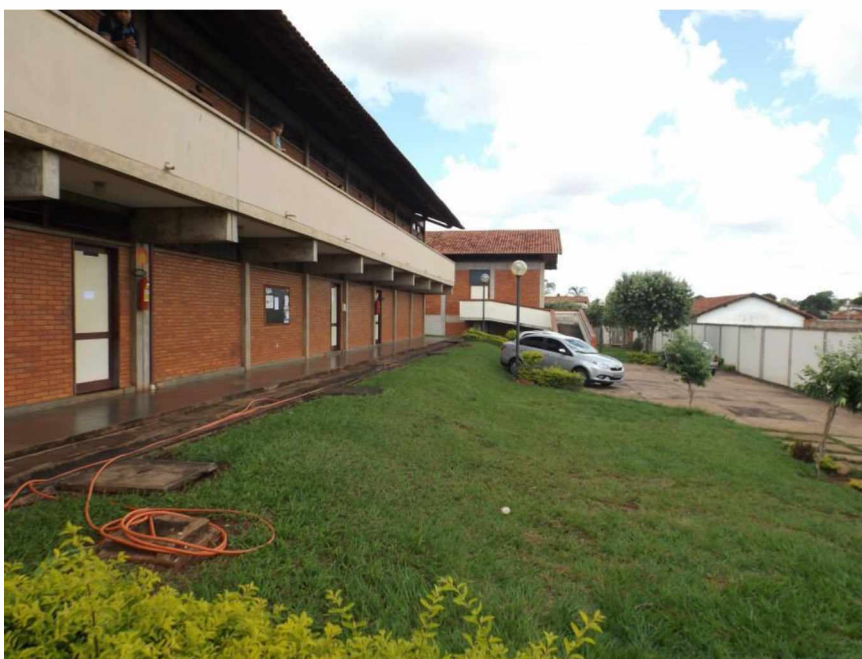
Figura 19 - Vista do corredor do segundo bloco do térreo.
