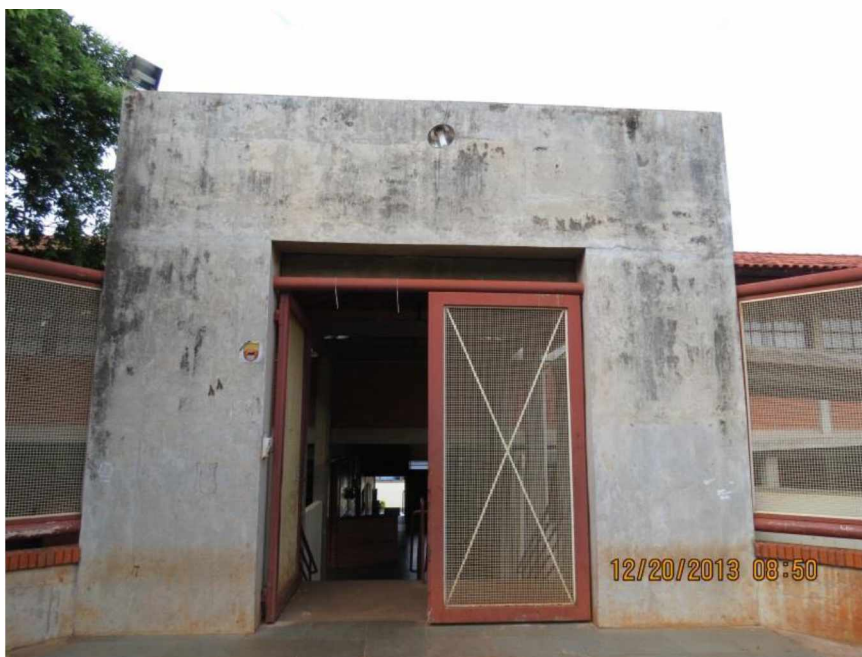
Figura 6 - Vista do portão de entrada do CEM.
