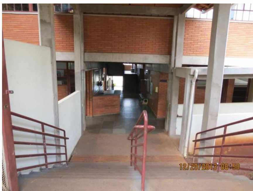
Figura 7 - Vista das escadas que dão acesso à entrada do CEM.
