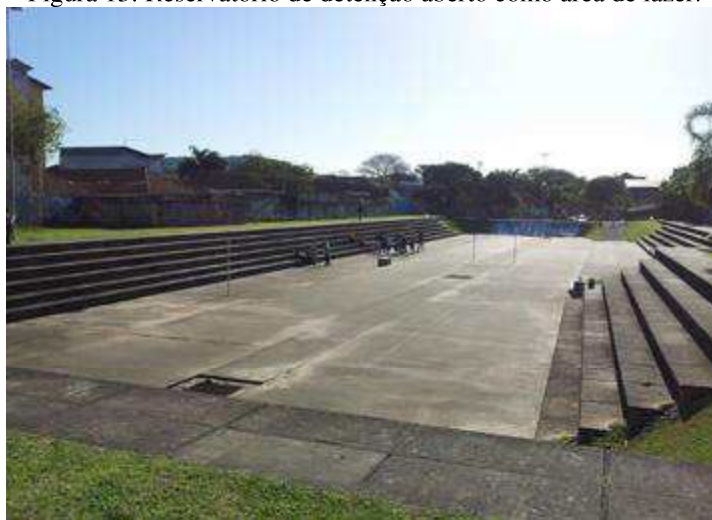
Figura 13: Reservatório de detenção aberto como área de lazer.
