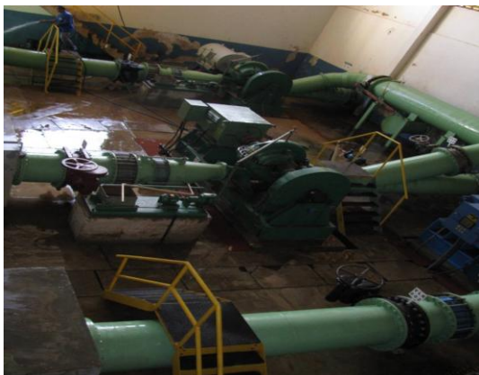
Foto 28 - Bombeamento da água.
