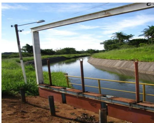
Foto 26 - Canal de captação da água.
