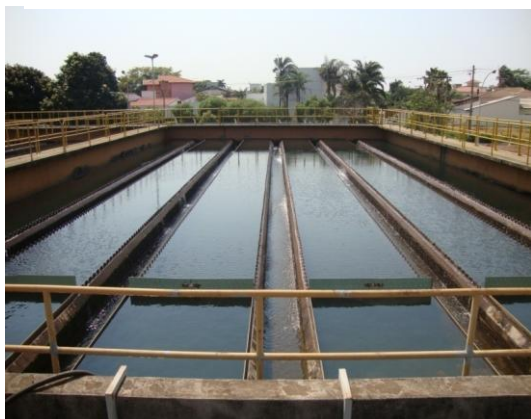
Foto 32 - Tanque de decantação.
