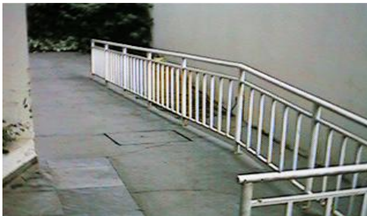
FIGURA 15 – Fotografia da rampa de entrada - Casa 2
