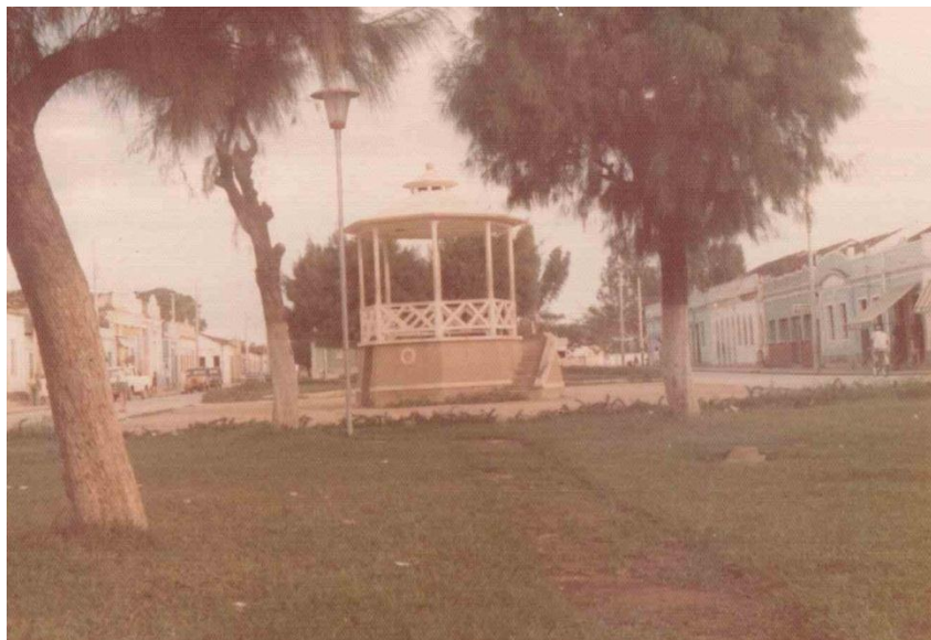
Fotografia 2: Imagem do coreto que foi demolido. Fonte: ONG PRESERVAR, fotografia da década de 1970.
