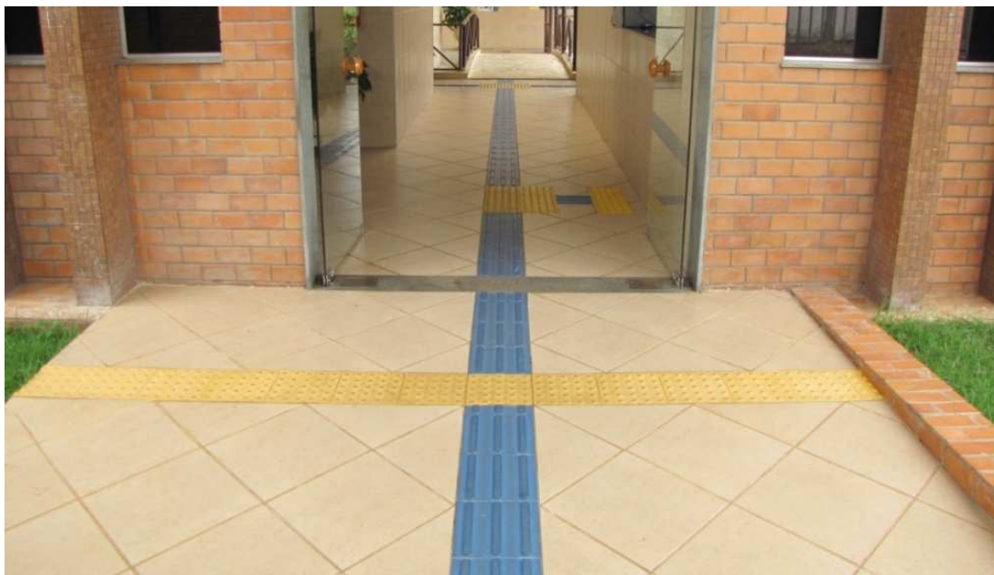
Figura 17 – Fotografia do rol de entrada com pista tátil do Instituto de Cegos do Brasil Central.
