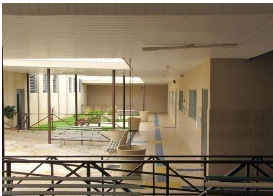
A - Vista geral do corredor com pista tátil
