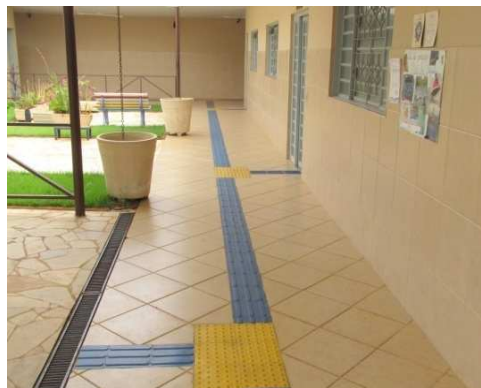
B - Pista tátil para estimulação e locomoção das pessoas com deficiência visual
