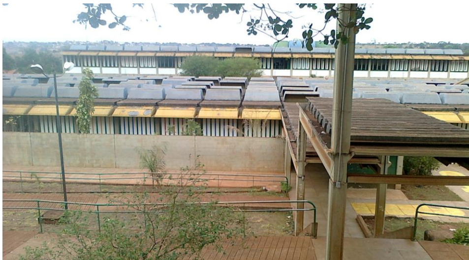
FIGURA 23 - CAIC - Área coberta construída.
