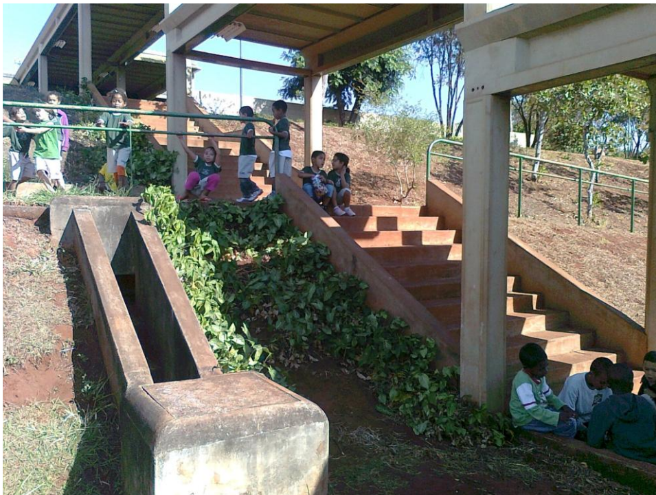
FIGURA 10 - Galeria Pluvial – CAIC.
