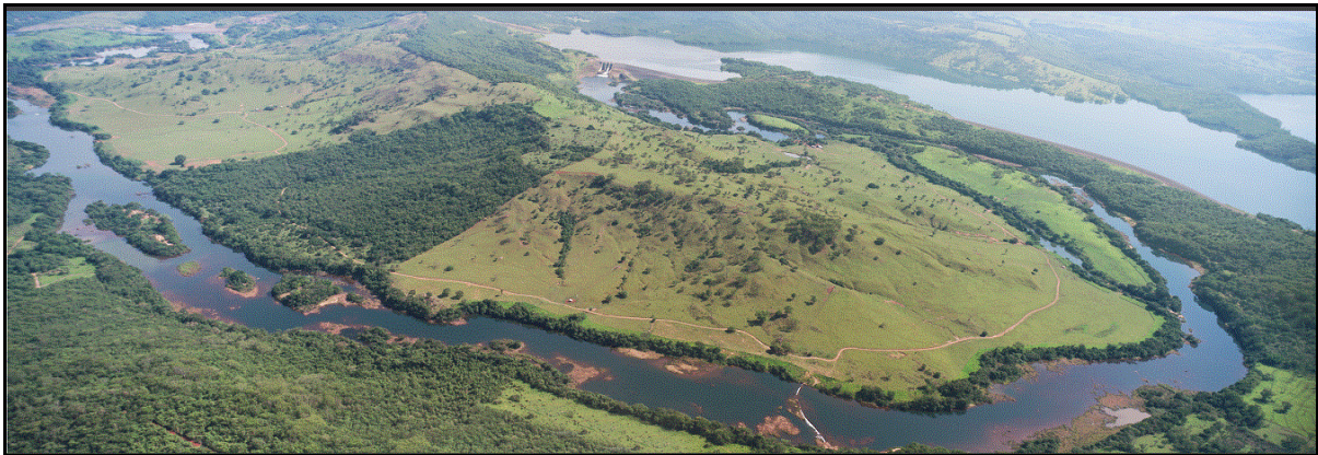
Foto 1 - Vista aérea do AHE Amador Aguiar I.
