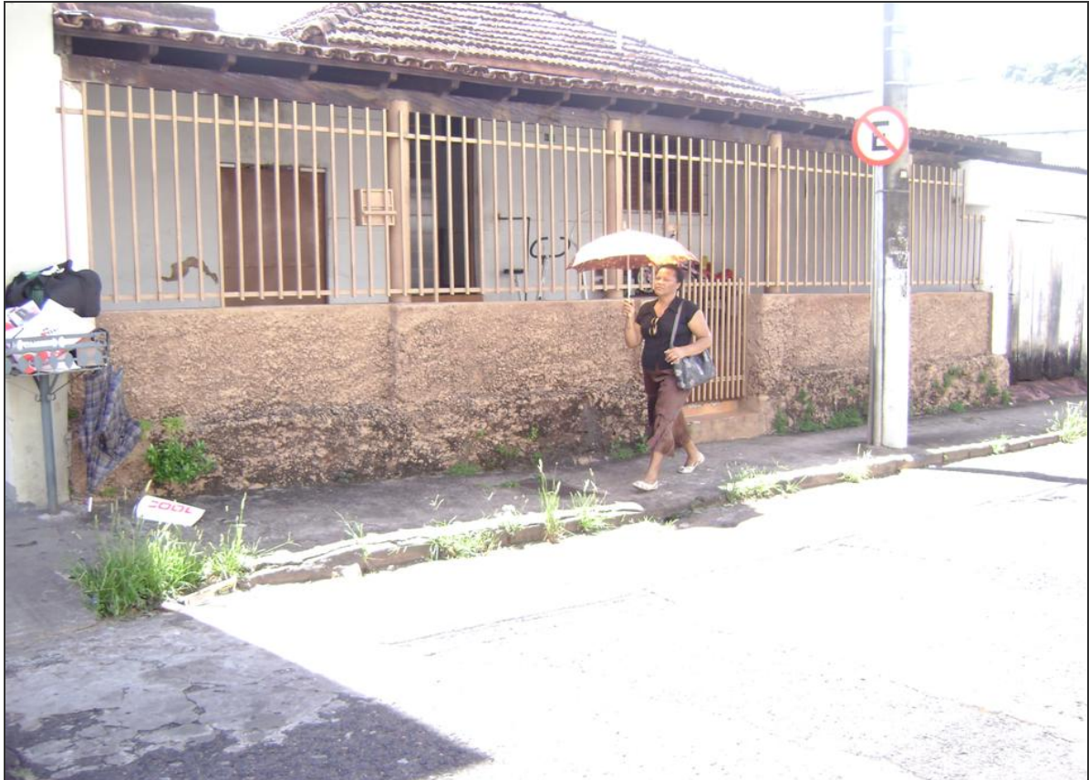
Foto 2 - Uberlândia (MG): calçada estreita e casa com arquitetura antiga, sem garagem, na Rua Dom Barreto, Bairro Fundinho (2010)
