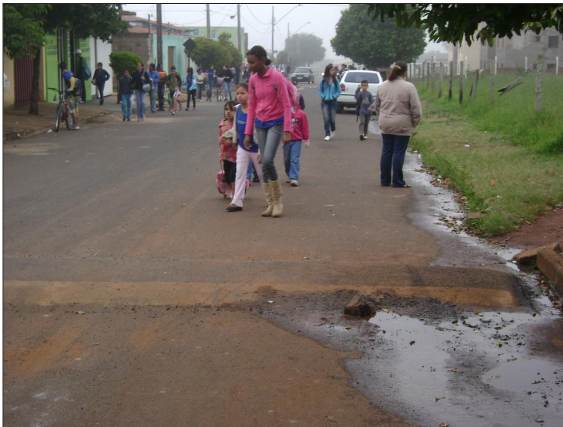
Foto 22 - Uberlândia (MG): calçada sem pavimentação, na Rua Antônio Bernardes da Costa, próximo à Escola Municipal Professor Jacy de Assis (2009)
