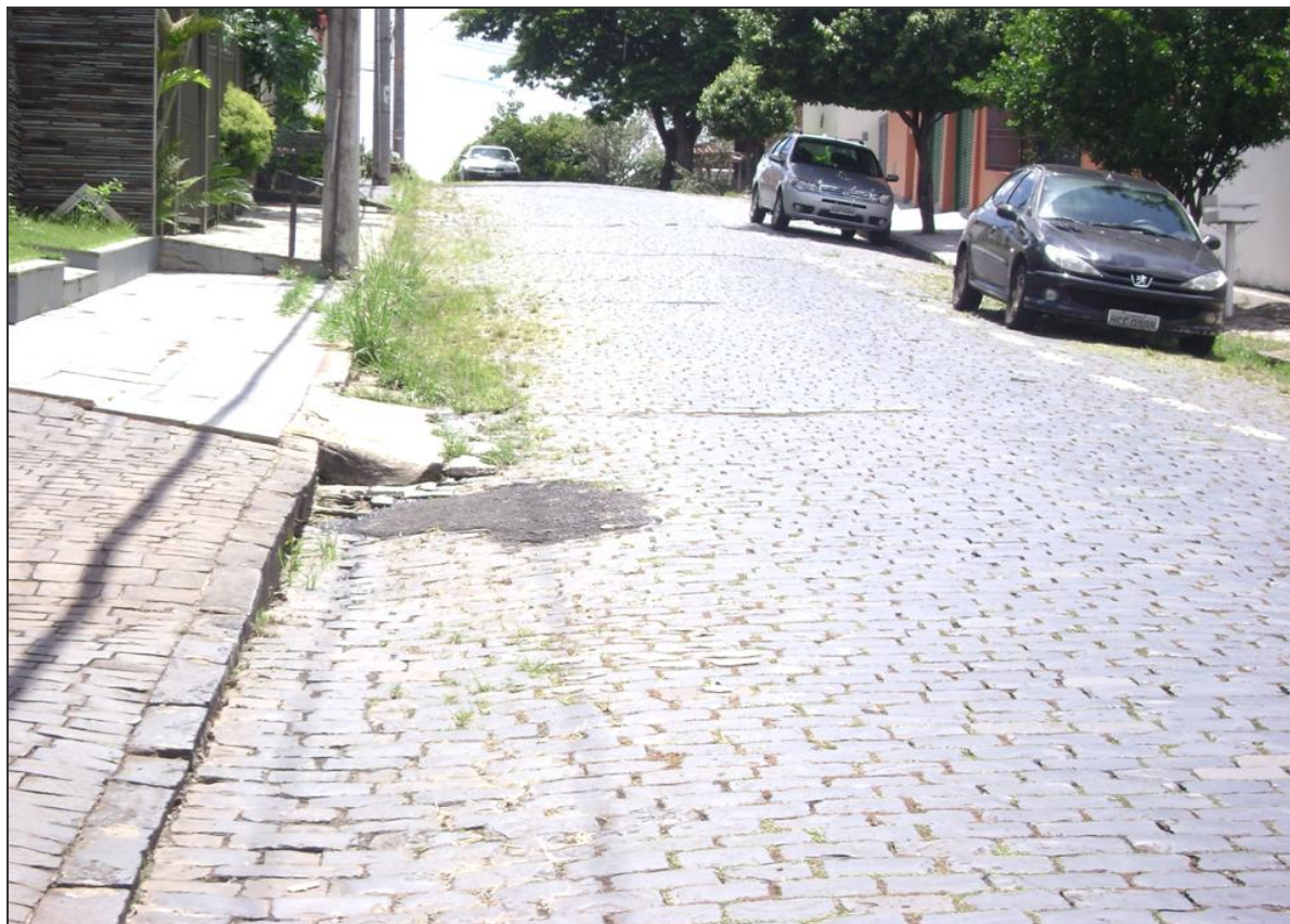
Foto 3 - Uberlândia (MG): pavimentação não asfáltica na Rua Barão de Camargos, Bairro Fundinho (2010)
