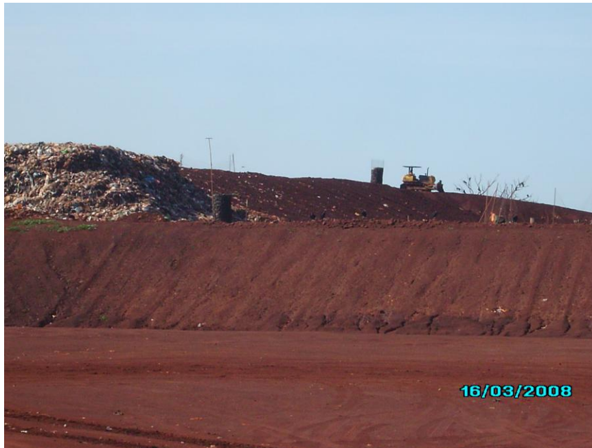
Figura 1: Local onde a terra está sendo retirada, e também a célula onde os resíduos da cidade estão sendo depositados.
