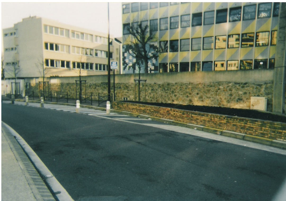
Figura 4 – Barreiras de proteção em frente ao Institut Notre-Dame, contra possíveis ataques de carros-bomba - Bourg-La-Reine /França (2003) Autor.: ULHÔA, L. M. nov. 2003
