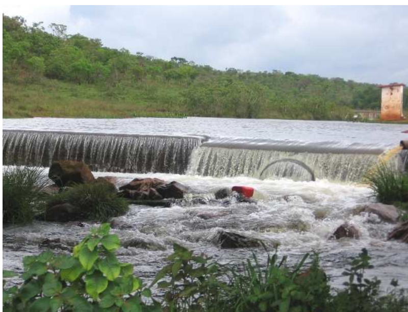
FIGURA 23: Captação de água para o abastecimento da cidade de Iraí de Minas. ORG.: SILVA, Emerson Malvino; 2006.
