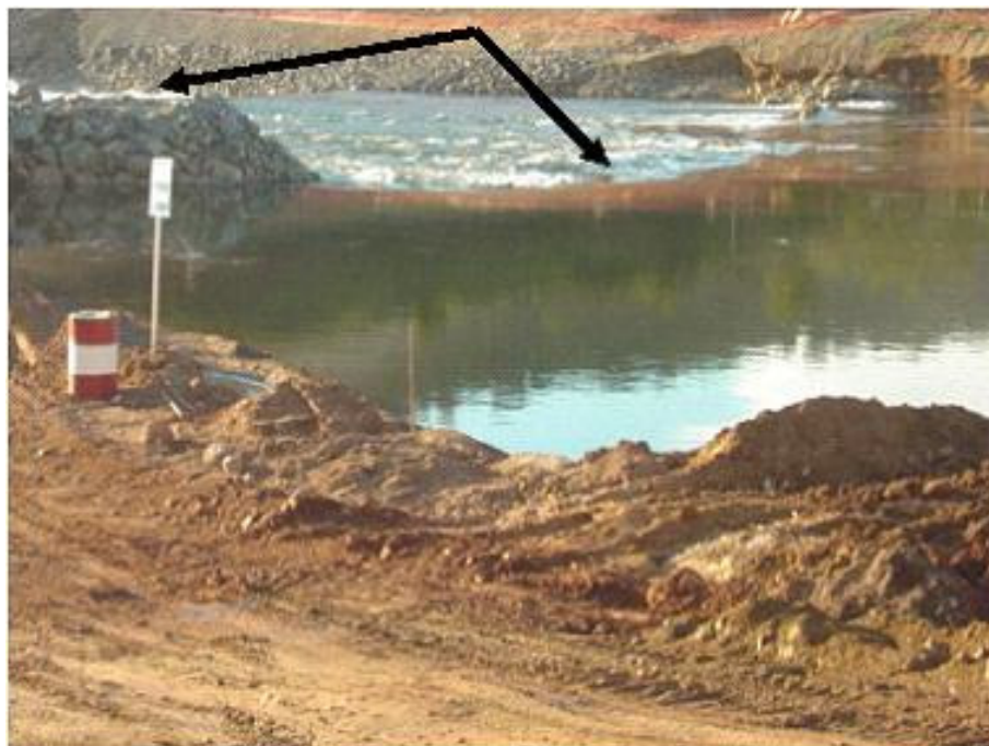
Foto 65 - Entrada da água do rio Araguari no túnel após o desvio. Autora: LEMOS, J. C. Agosto, 2004.
