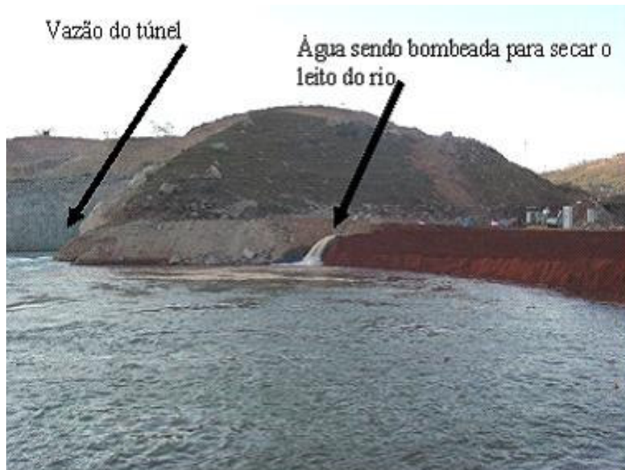
Foto 66 - Abertura do túnel para dar vazão a água depois do desvio do rio e barramento no rio para secar e dar início a construção da barragem. Autora: LEMOS, J. C. Agosto, 2004.
