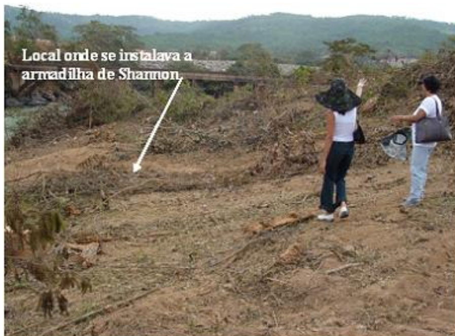
Foto 57 - Desmatamento da margem esquerda do rio Araguari – Ponte do Pau Furado, para construção da barragem da UHE Capim Branco I, Município de Uberlândia.
