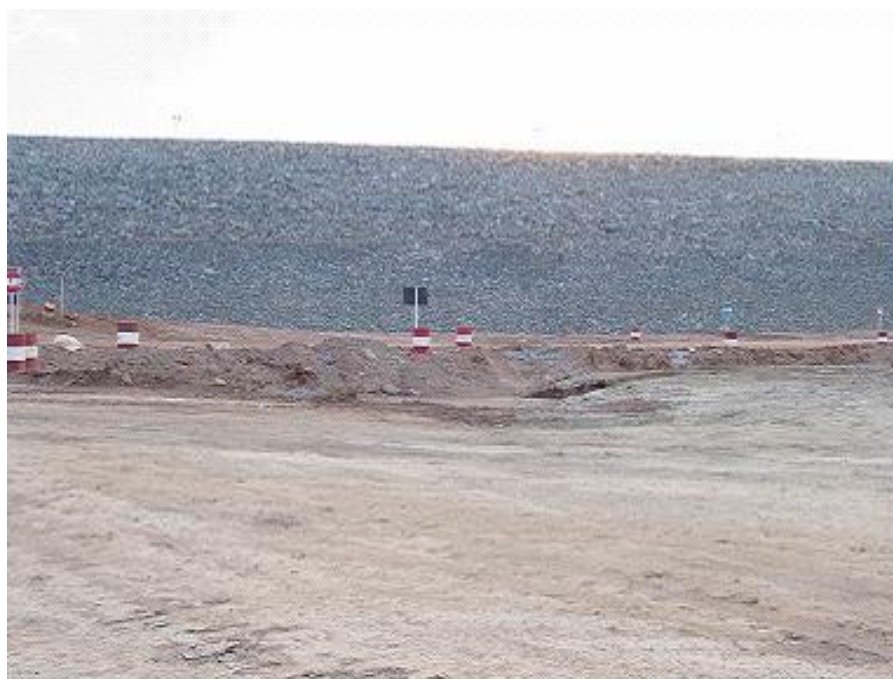
Foto 79 - Penúltimo mês da construção da barragem da UHE Capim Branco I. Autora: LEMOS, J. C. Outubro, 2005.
