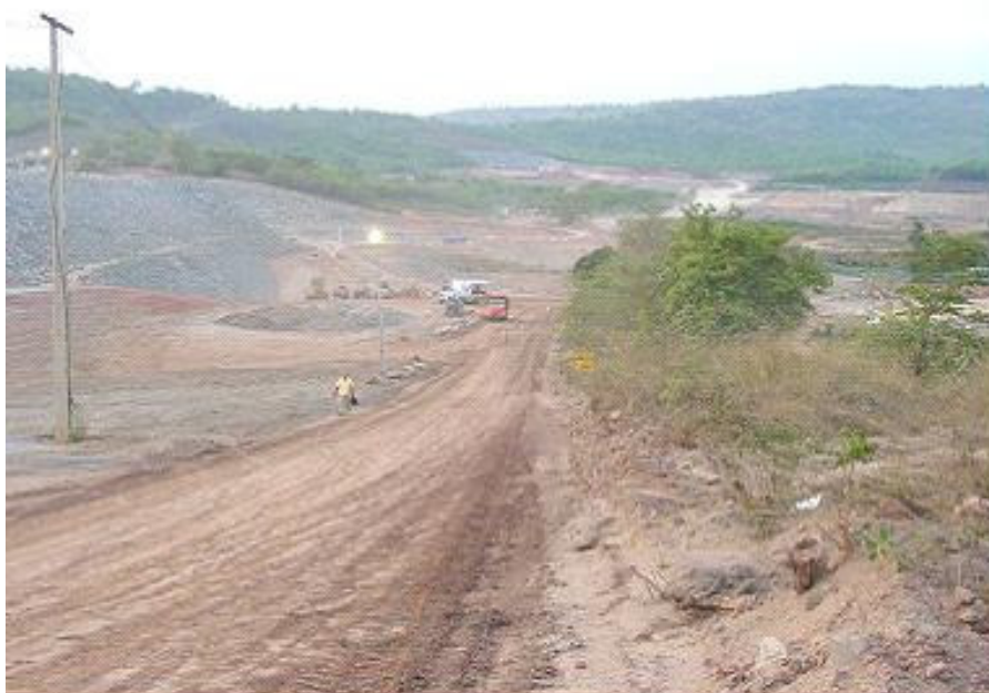
Foto 81 - Penúltimo mês da construção da barragem da UHE Capim Branco I. Autora: LEMOS, J. C. Outubro, 2005.
