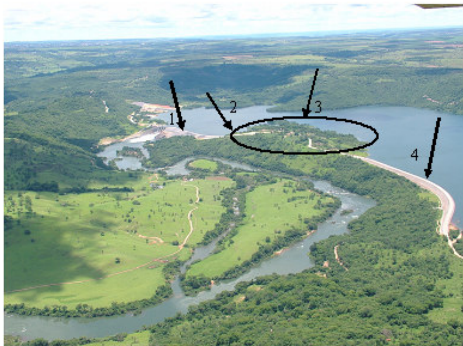
Foto 94 - Da esquerda para a direita: (1) barragem, (2) ponto de controle, (3) Assentamento Vida Nova e (4) dique. Fonte: CONSÓRCIO CAPIM BRANCO ENERGIA (2006). Adaptado por: LEMOS, J. C. 2007.
