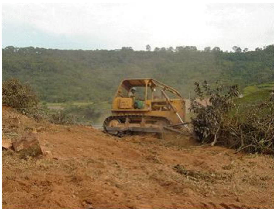
Foto 61 - Desmatamento da margem esquerda do rio Araguari para construção da barragem da UHE Capim Branco I, Município de Uberlândia. Autor: LIMA, S. do C. Maio, 2004.
