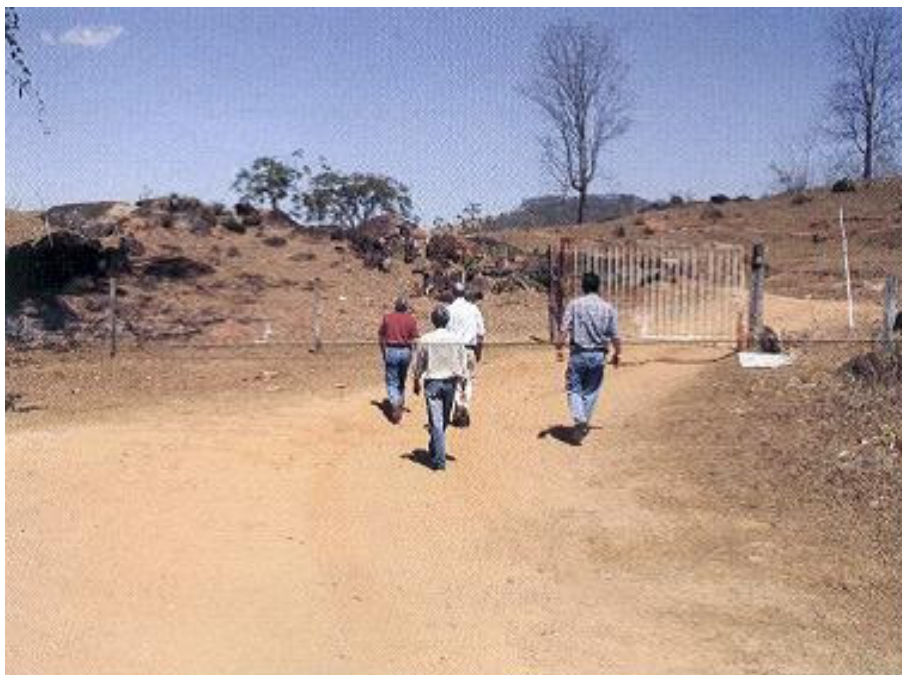
Foto 49 - Área do Túnel de Desvio da água do rio Araguari, para a construção da barragem da UHE Capim Branco I, na margem direita do rio Araguari, em 5 de setembro de 2003.
