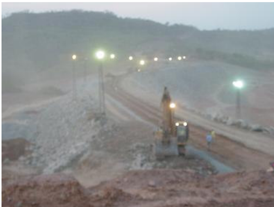
Foto 84 - Penúltimo mês da construção da barragem da UHE Capim Branco I. Autora: LEMOS, J. C. Outubro, 2005.
