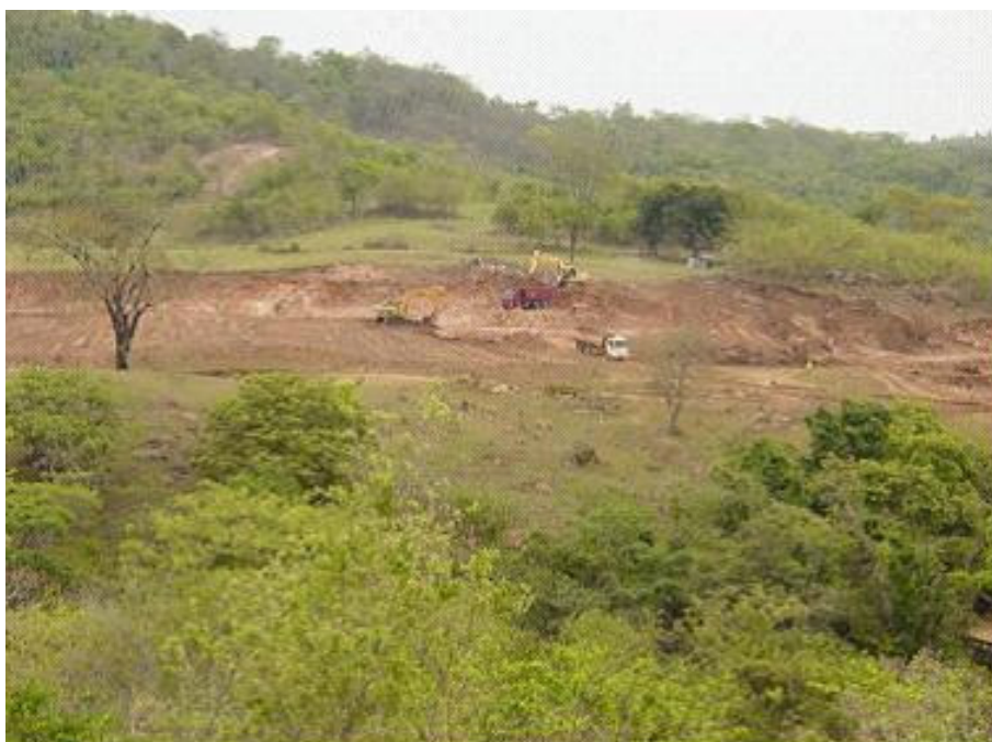
Foto 54 - Máquinas, caminhões e pessoas trabalhando para a construção da barragem da UHE Capim Branco I, na margem direita do rio Araguari, Município de Araguari – MG. Autora: LEMOS, J. C. Novembro, 2003.
