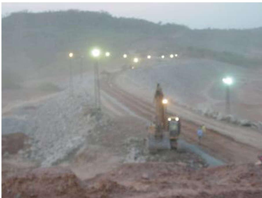
Foto 85 - Penúltimo mês da construção do dique da UHE Capim Branco I. Início do dique sentido Uberlândia-Araguari. Autora: LEMOS, J. C. Outubro, 2005.
