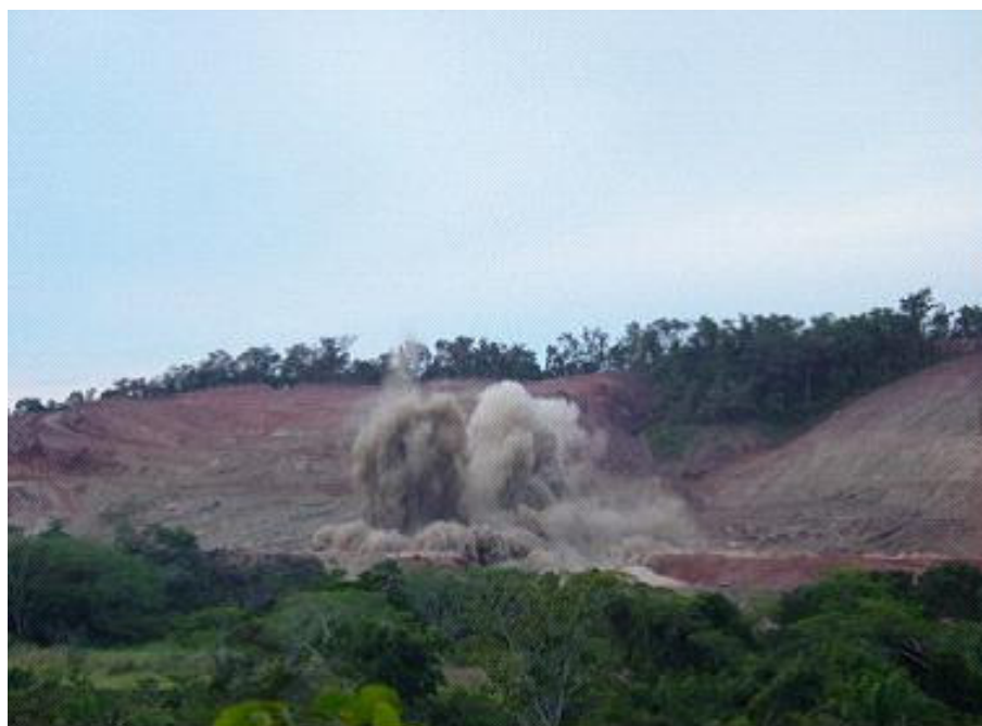
Foto 55 - Explosão no local de construção da UHE Capim Branco II. Autora: LEMOS, J. C. Maio, 2004.
