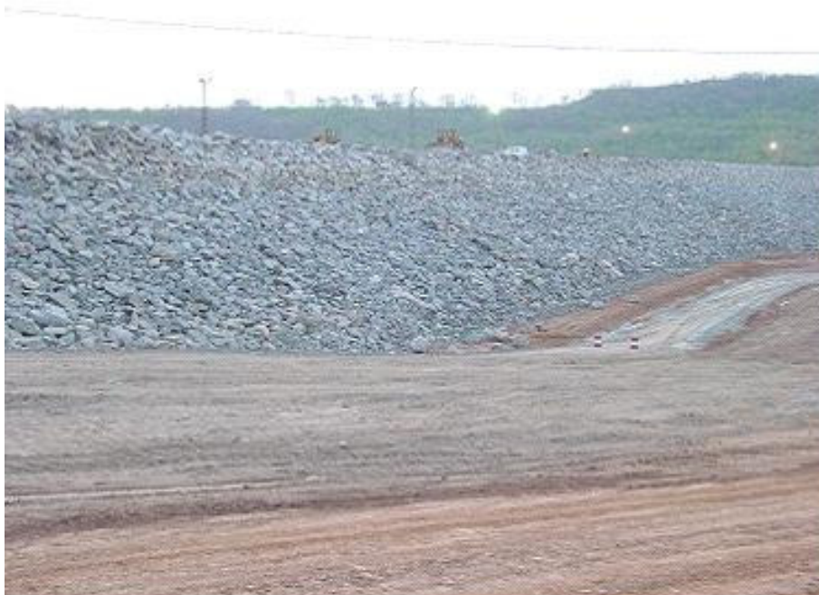
Foto 82 - Penúltimo mês da construção da barragem da UHE Capim Branco I. Autora: LEMOS, J. C. Outubro, 2005.
