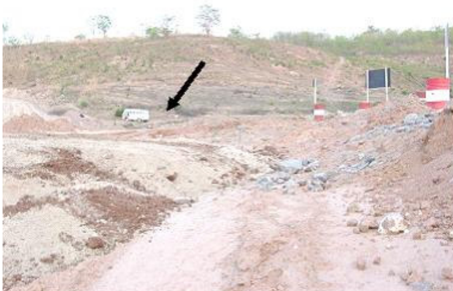
Foto 80 - Kombi da UFU no ponto próximo a margem do rio Araguari no penúltimo mês da construção da barragem da UHE Capim Branco I. Autora: LEMOS, J. C. Outubro, 2005.
