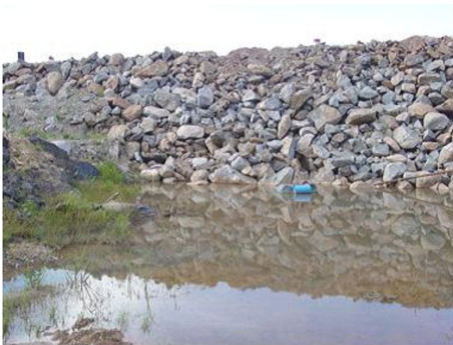
Foto 73 - Água empoçada que vazava entre as rochas do represamento para o desvio do rio Araguari. Autora: LEMOS, J. C. Março, 2005.
