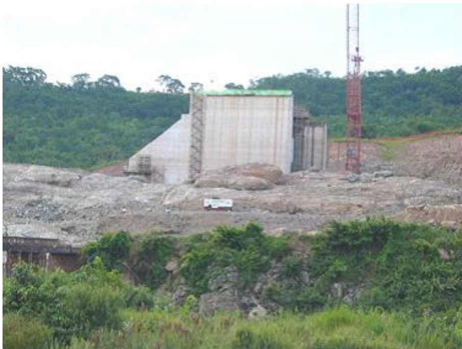
Foto 72 - Estrutura de concreto para a barragem e um guindaste. Autora: LEMOS, J. C. Março, 2005.
