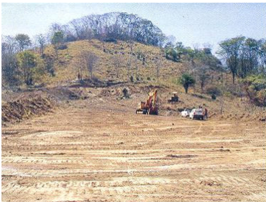
Foto 48 - Área da futura Casa de Força da UHE Capim Branco I, na margem direita do rio Araguari, em 5 de setembro de 2003.
