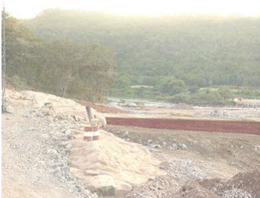
Foto 76 - Início da construção da barragem da UHE Capim Branco I. Autora: LEMOS, J. C. Abril, 2005.
