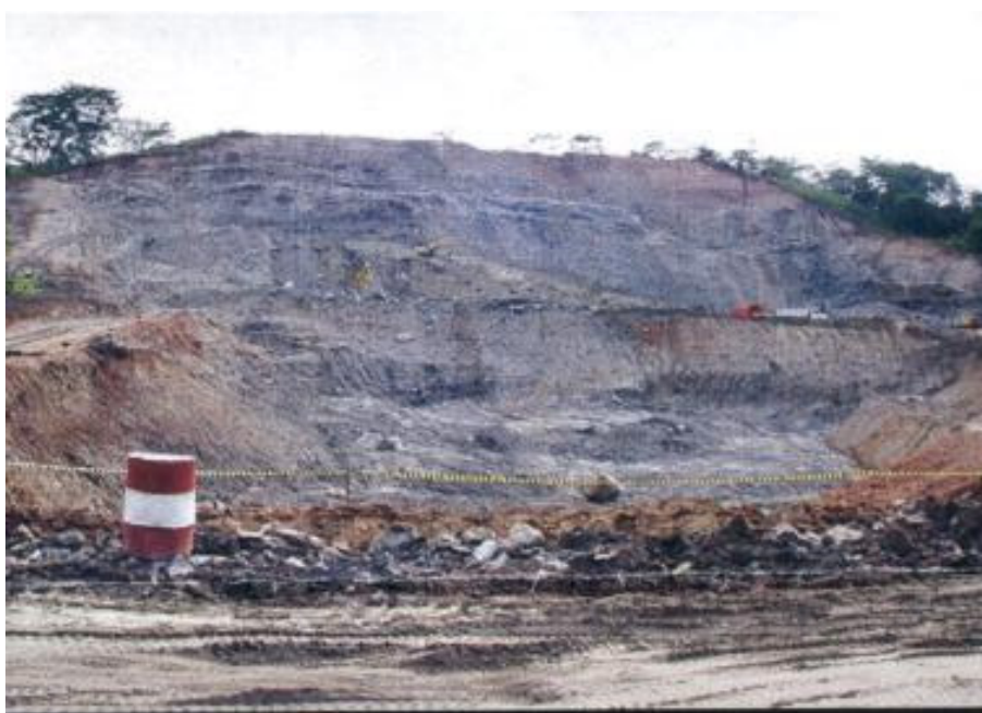
Foto 51 - Escavação para a construção da Casa de Força em 28 de novembro de 2003.
