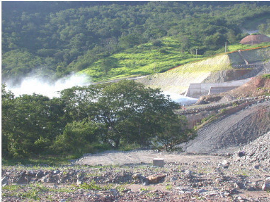
Foto 92 - Comportas abertas após enchimento do lago. Autora: FERRETE, J. A. Janeiro, 2006.
