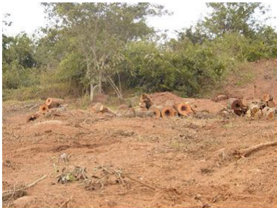
Foto 59 - Desmatamento da margem esquerda do rio Araguari para construção da barragem da UHE Capim Branco I, Município de Uberlândia. Autor: LIMA, S. do C. Maio, 2004.
