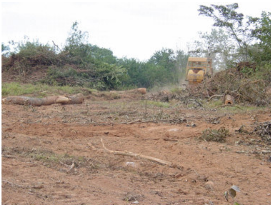
Foto 60 - Desmatamento da margem esquerda do rio Araguari para construção da barragem da UHE Capim Branco I, Município de Uberlândia. Autor: LIMA, S. do C. Maio, 2004.
