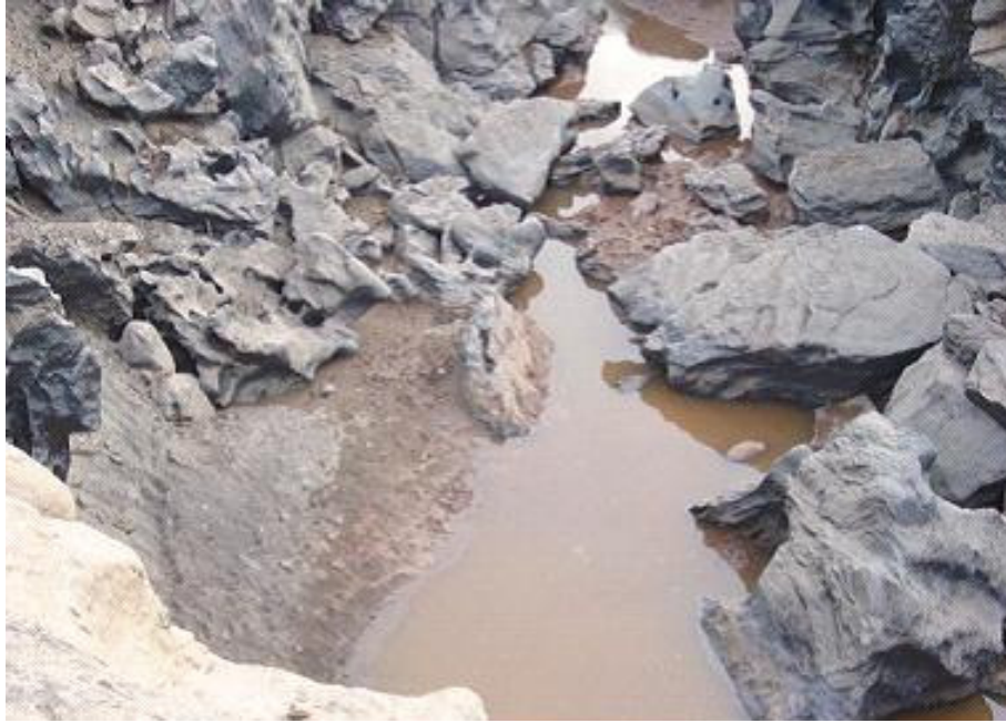
Foto 68 - Fundo do leito do rio Araguari após desvio da água para o túnel. Autora: LEMOS, J. C. Agosto, 2004.
