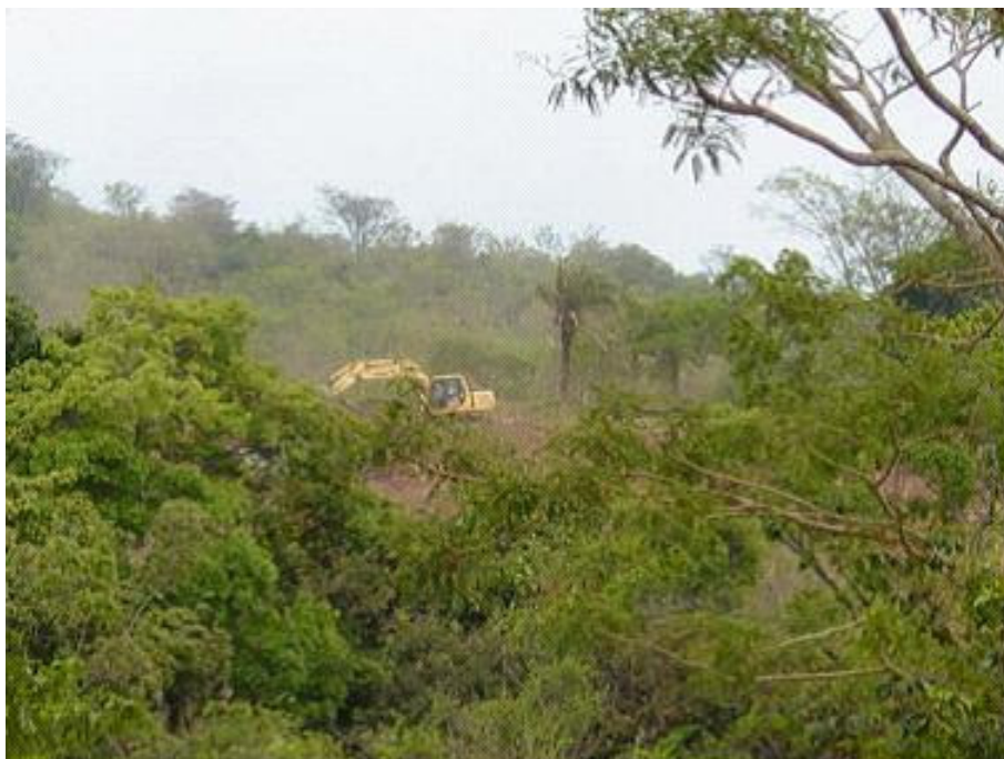
Foto 53 - Máquina trabalhando para a construção da barragem da UHE Capim Branco I, na margem direita do rio Araguari, Município de Araguari – MG. Autora: LEMOS, J. C. Novembro, 2003.
