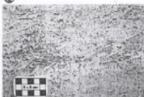
Prédio da Secretaria Municipal de Educação Revestimento em travertino italiano, notando-se a resina usada para obturar os poros.
