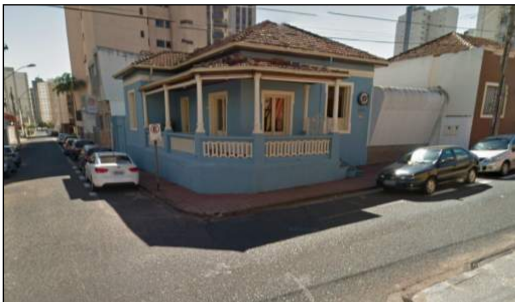
Foto 42 – Uberlândia (MG) – Escritório de arquitetura em edifício de valor histórico – 2013
