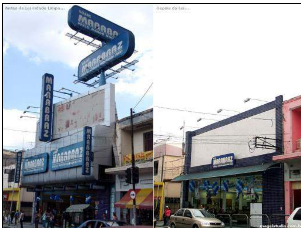
Foto 57 – Exemplo de readequação de fachada em edificação localizada na cidade de São Paulo
