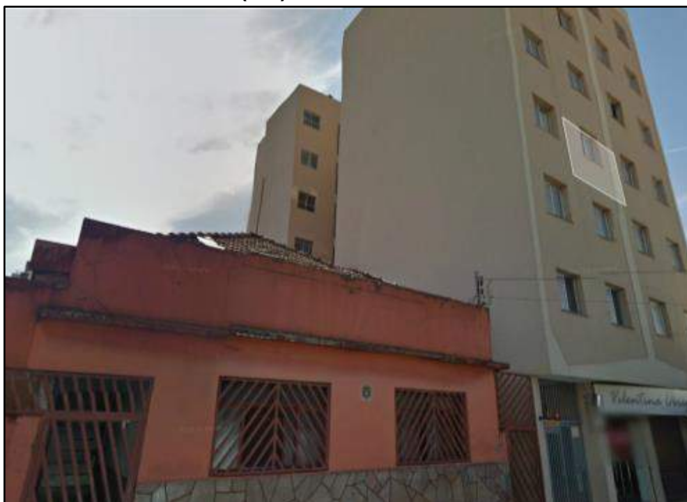
Foto 36 – Uberlândia (MG) – Fachada do edifício Verona – 2013
