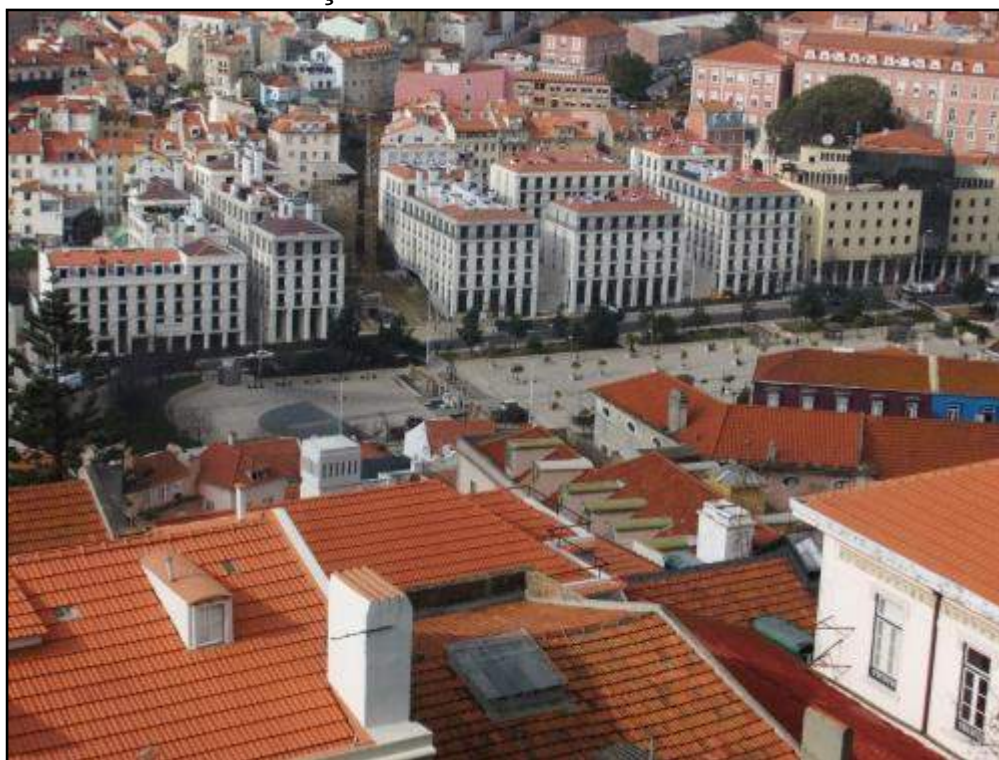
Foto 16 – Obras de reabilitação de moradias no Rossio em Lisboa – 2011
