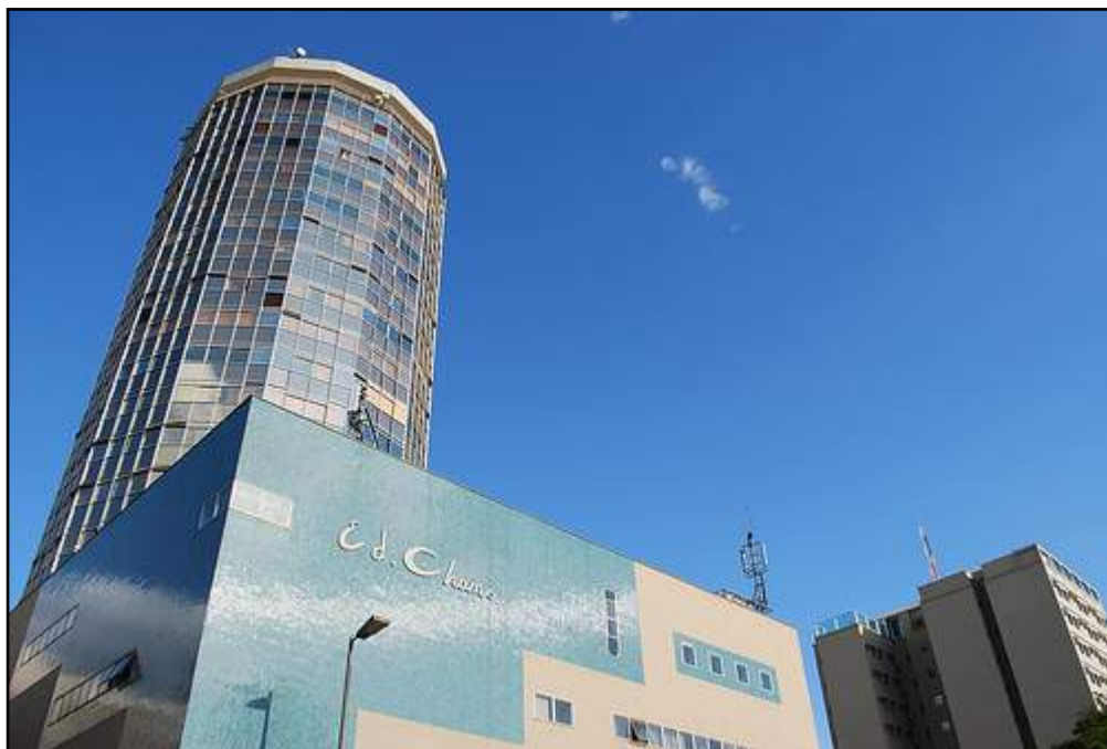
Foto 26 – Uberlândia (MG) – Edifício Chams, localizado junto à Praça Tubal Vilela – 2010
